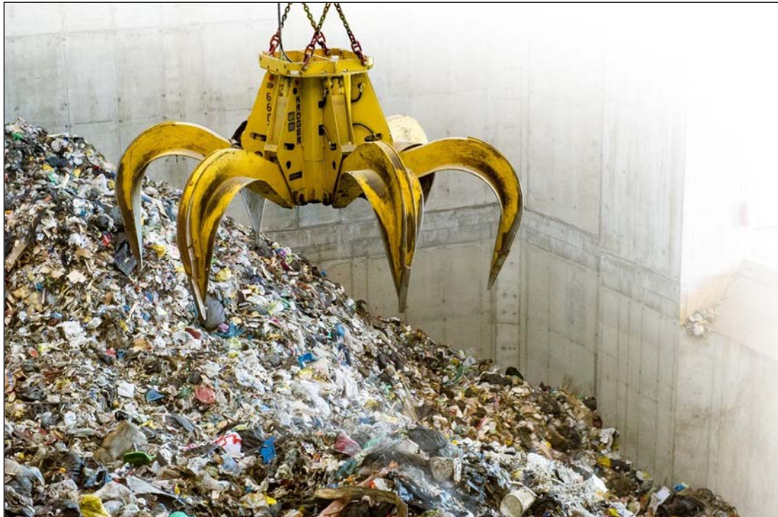
Kuva 3-3. Jätebunkkeri ja jätettä syöttävä kahmari.
