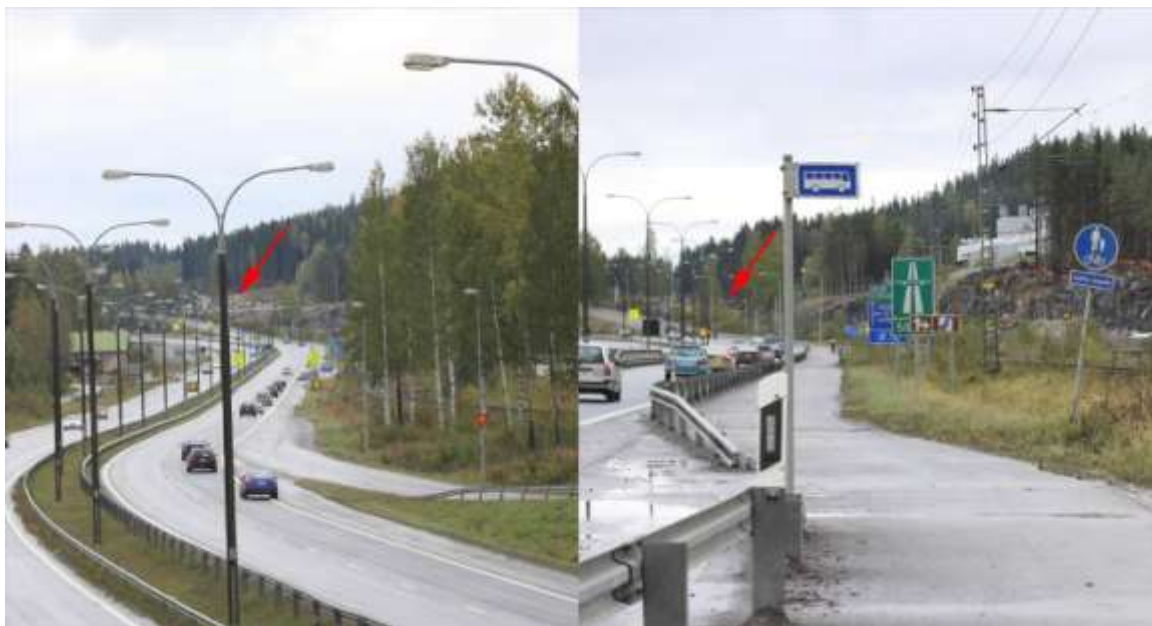
Kuva 9.3/8. Näkymät Vt 5:n yli Sorsasalons liittymästä ja alhaalta tien tasolta (kuvat otettu 22.09.2010). Punaisella nuolella on osoitettu reunapenkereen sijainti.
