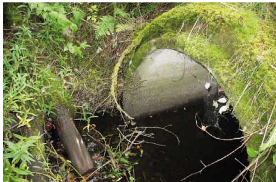
Kuva 5.5 Valkjärven lasku-uoma alittaa valtatiepenkereen. Kuva itäpuolelta.
