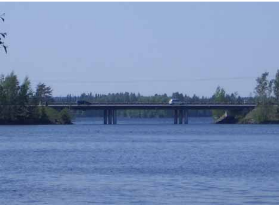
Kuva 5.27. Kuvasovitus, jossa on esitetty n. 1,4m korkea läpinäkyvä melueste. Uusien siltojen pilarit ja kansirakenteet peittävät näkymää katselupisteestä riippuen. Siltakannen paksuudella on vaikutusta sillan maisemakuvalliseen hallitsevuuteen.
