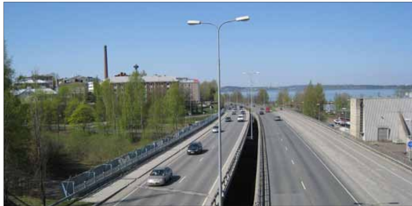
Kuva 11.6. Rantaväylä Armonkallion ja Naistenlahden voimalaitoksen kohdalla.
