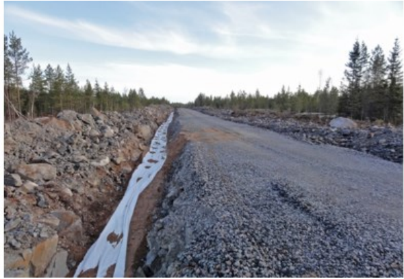
Kuva 4.14 Maakaapelit upotetaan huoltoteiden yhteyteen (FCG Finnish Consulting Group Oy).
