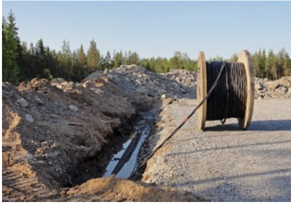
Kuva 4.14 Maakaapelit upotetaan huoltoteiden yhteyteen (FCG Finnish Consulting Group Oy).
