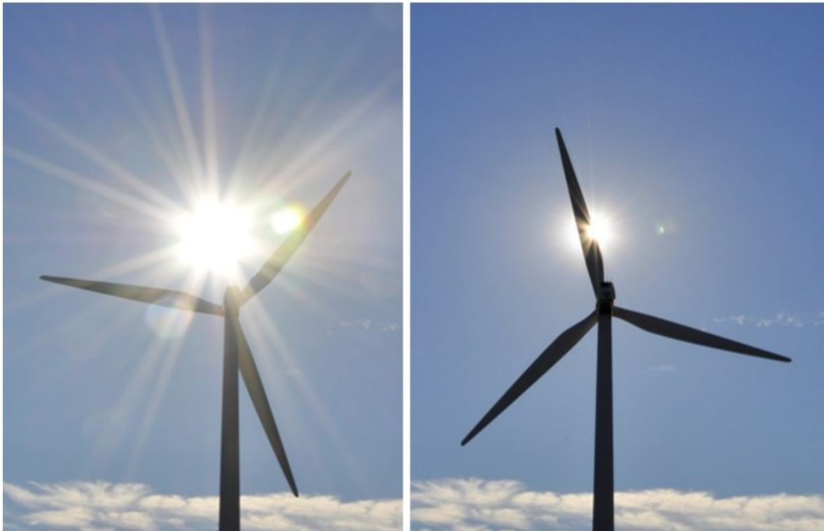
Kuva 16.25 Tuulivoimaloiden lavat aiheuttavat pyöriessään vilkkumista ja varjon välkkymistä aurinkoisella säällä.
