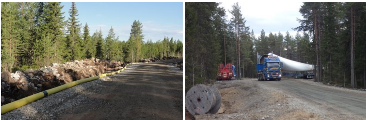
Kuva 4.8 Vasemmalla esimerkki tuulivoimapuiston rakennus- ja huoltotiestä. Oikealla tuulivoimalan osia kuljetetaan erikoiskuljetuksina (FCG Finnish Consulting Group Oy).
