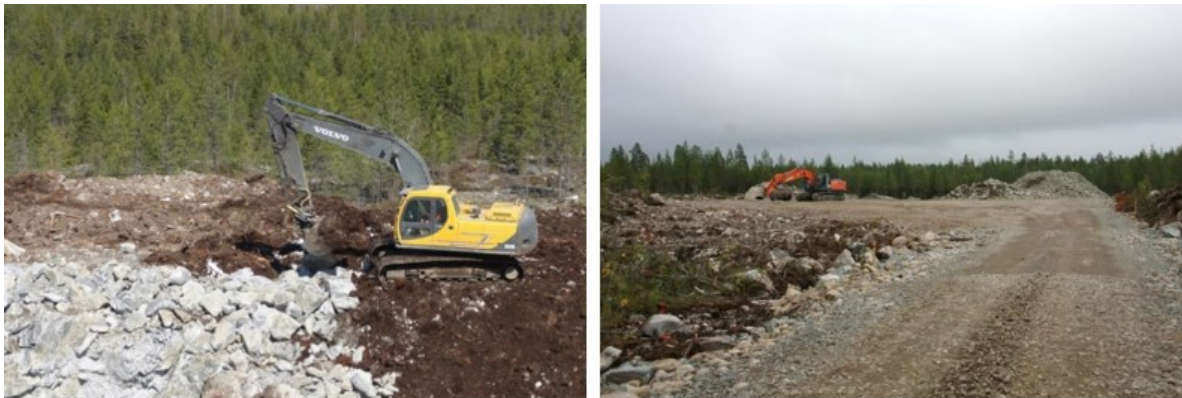
Kuva 4.13 Tuulivoimapuiston rakentaminen alkaa huoltoteiden ja pystytysalueiden rakentamisella (FCG Finnish Consulting Group Oy).
