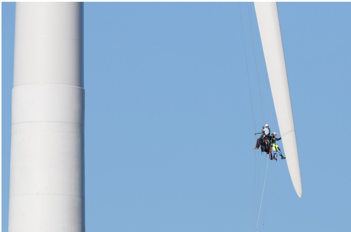
Kuva 4.20 Tuulivoimalan huoltotoimenpiteitä (FCG Finnish Consulting Group Oy).
