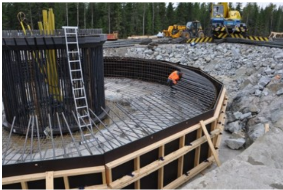
Kuva 4.15 Tuulivoimalan perustusten rakentamista (FCG Finnish Consulting Group Oy).
