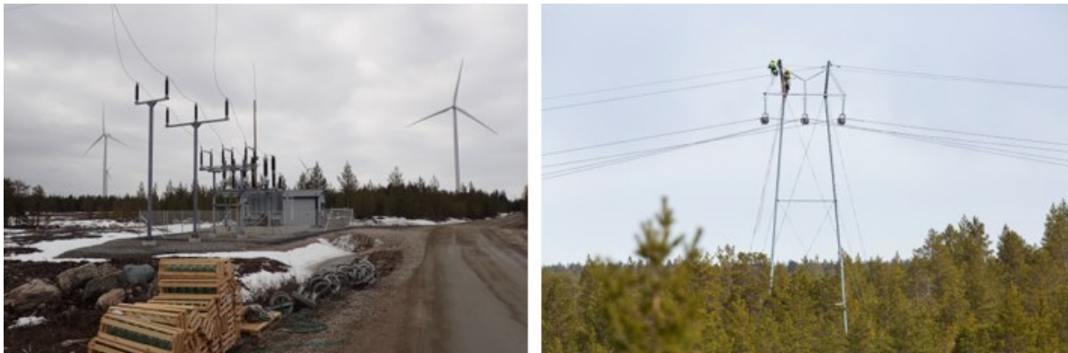
Kuva 4.18 Sähkösäseman ja voimajohdon rakentamista (FCG Finnish Consulting Group Oy).
