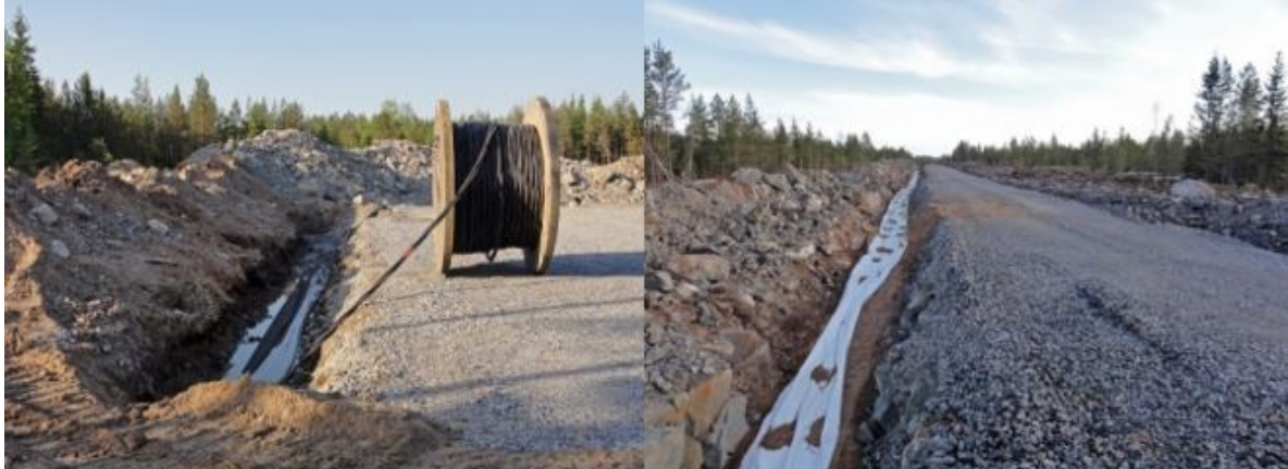
Kuva 5.11 Maakaapelit upotetaan huoltoteiden yhteyteen (Ville Suorsa, FCG).
