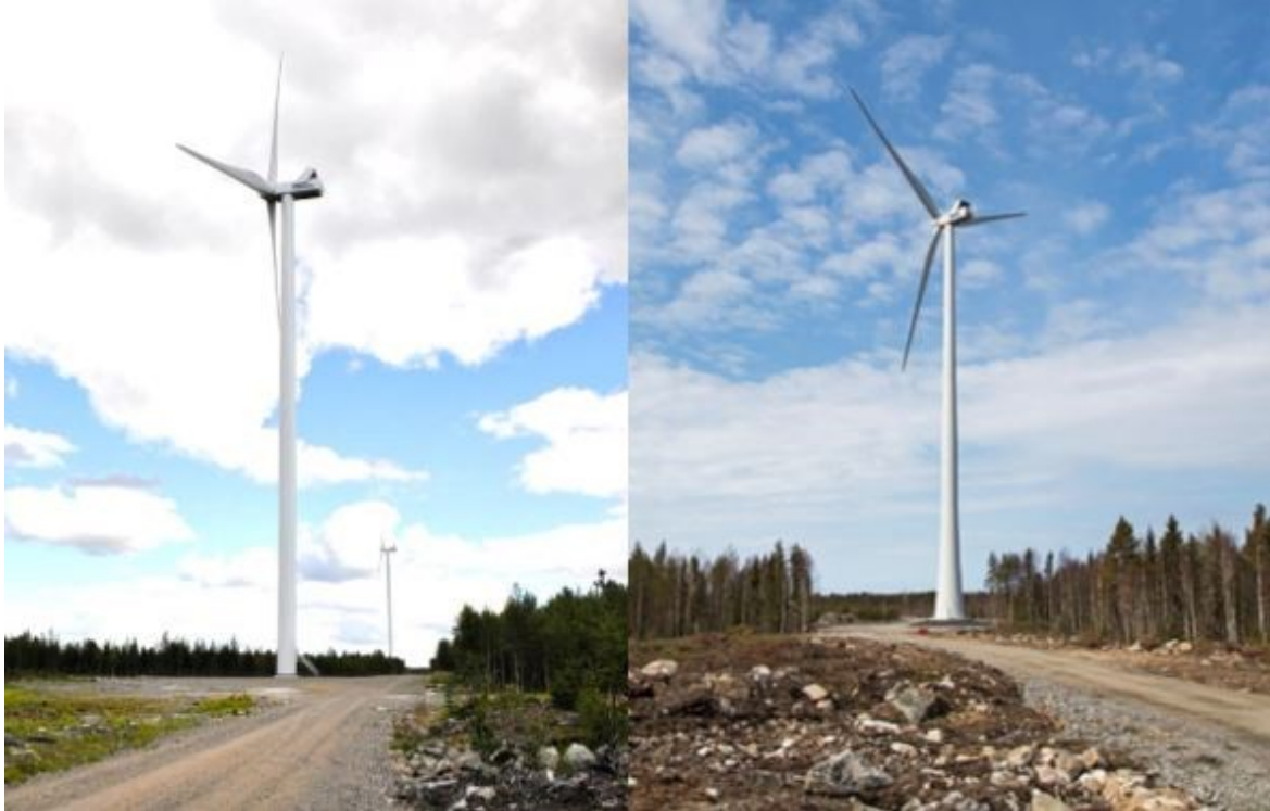
Kuva 5.2 Vasemmalla on esimerkki teräslieriötornista ja oikealla hybriditornista (Leila Väyrynen ja Ville Suorsa, FCG).
