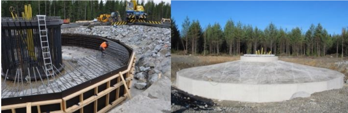
Kuva 5.12 Tuulivoimalan perustusten rakentamista (Leila Väyrynen, FCG).
