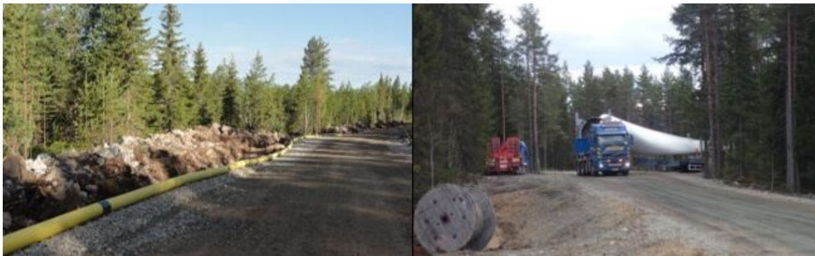
Kuva 5.7 Vasemmallä esimerkki tuulivoimapuiston rakennus- ja huoltotiestä. Oikealla tuulivoimalan osia kuljetetaan erikoiskuljetuksina (Ville Suorsa, FCG).
