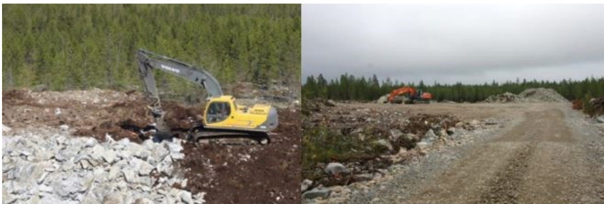
Kuva 5.10 Tuulivoimapuiston rakentaminen alkaa huoltoteiden ja pystytysalueiden rakentamisella (Ville Suorsa, FCG).
