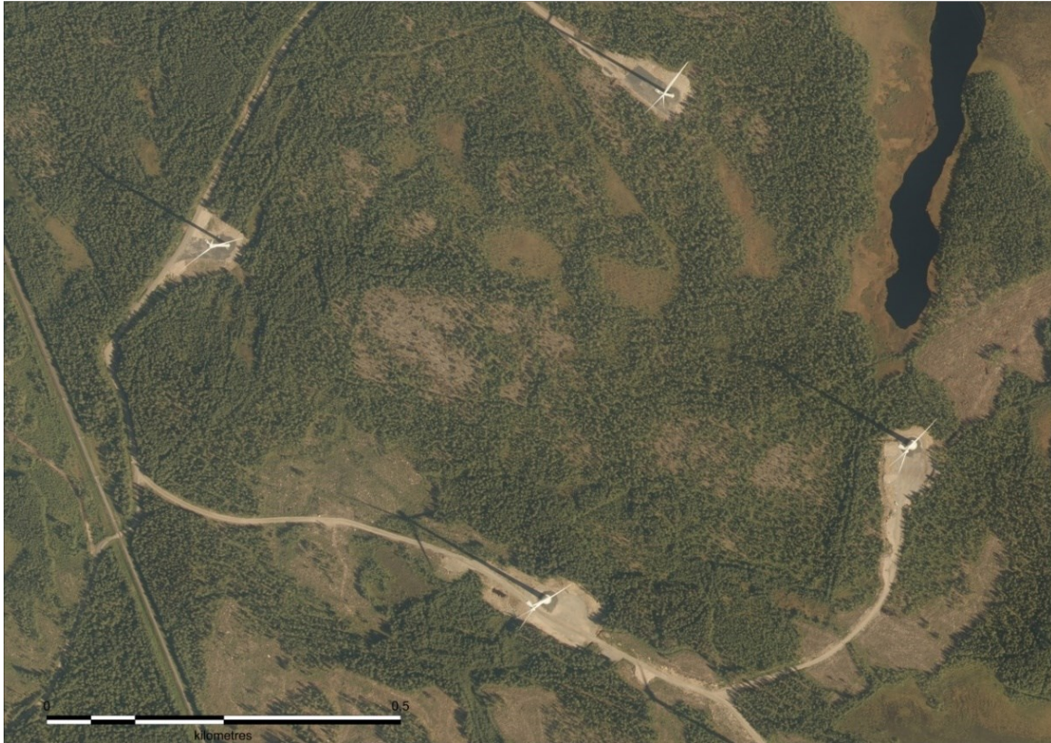
Kuva 5.1 Ilmakuva rakennetusta tuulivoimapuistosta (Maanmittauslaitos). Kuva ei ole Volkkilankankaan alueelta.
