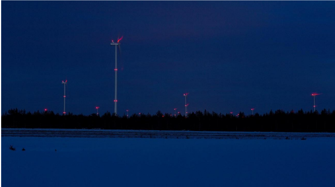
Kuva 5.5 Kiinteät punaiset lentoestevalot (Ville Suorsa, FCG).
