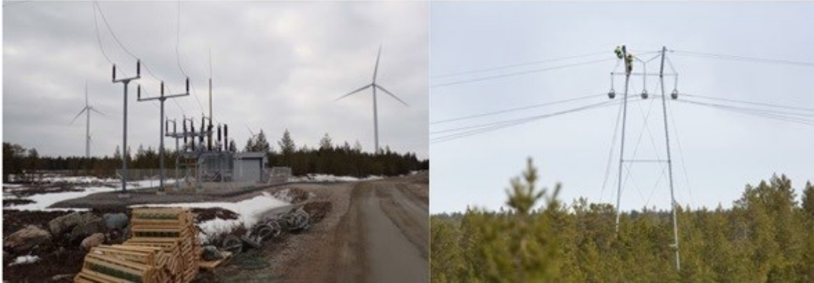
Kuva 5.15 Sähköaseman ja voimajohdon rakentamista (Ville Suorsa, FCG).
