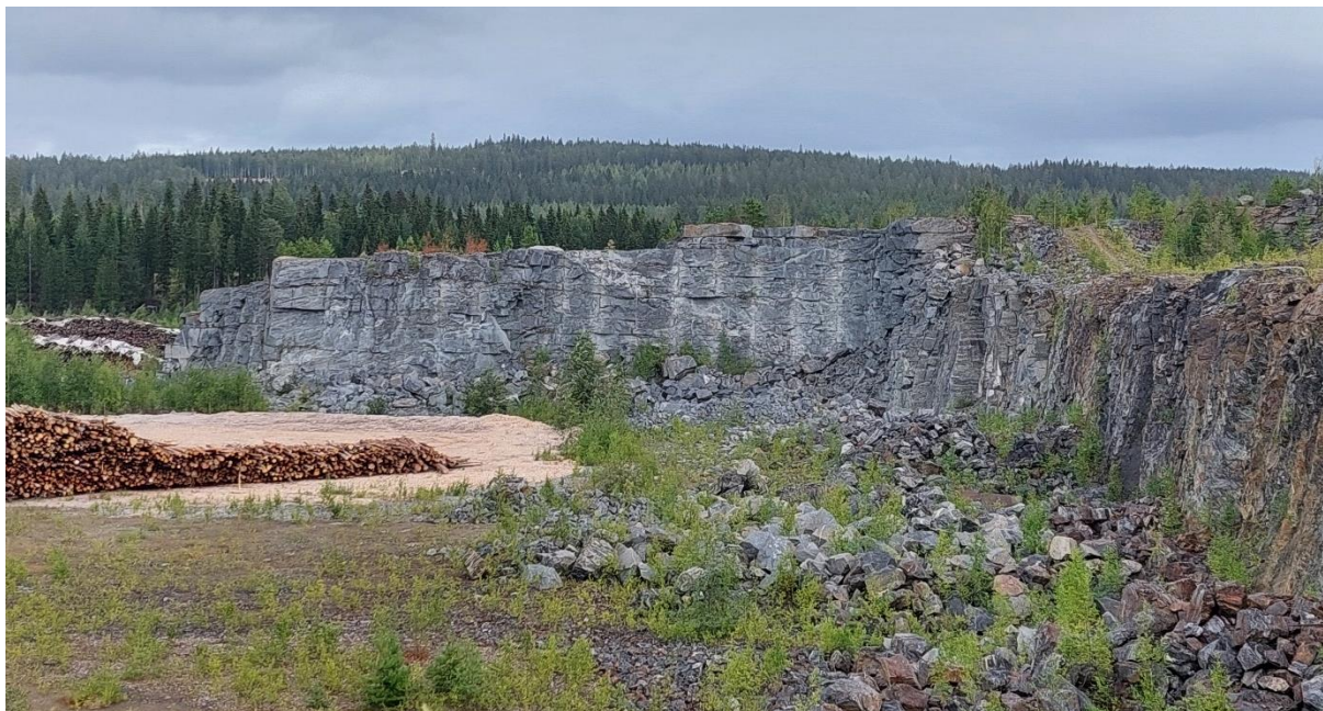
Kuva 15-2. Laitosalueella sijaitseva kallioleikkaus puukentän itäosassa.
