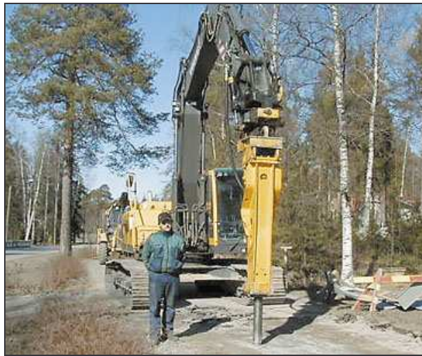
Kuva 12. Iskuvasaralla varustettu kaivinkone 8 .
