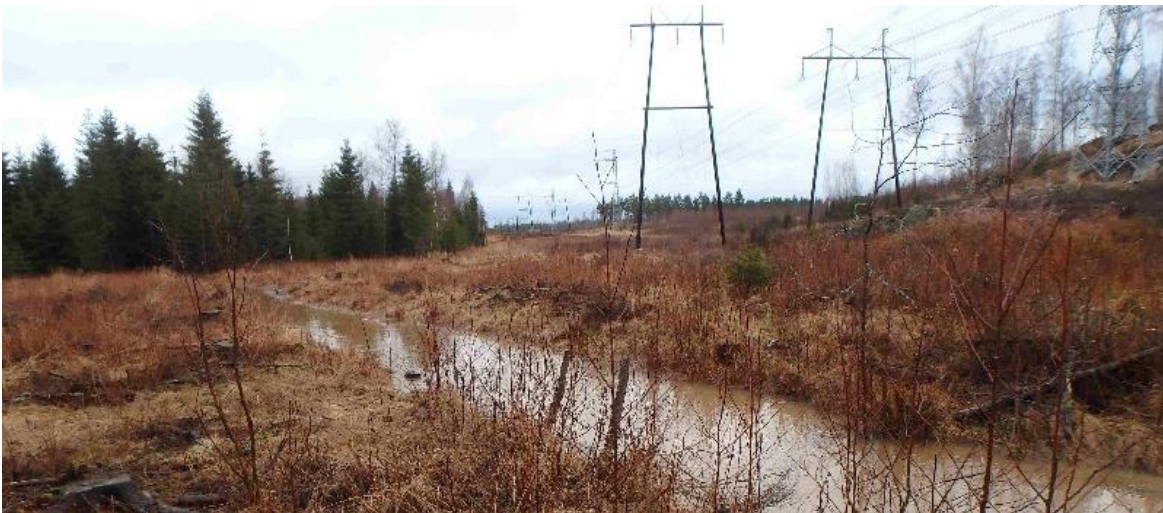
Kuva 3. Radan ja Öljytien välinen sähkölinja
