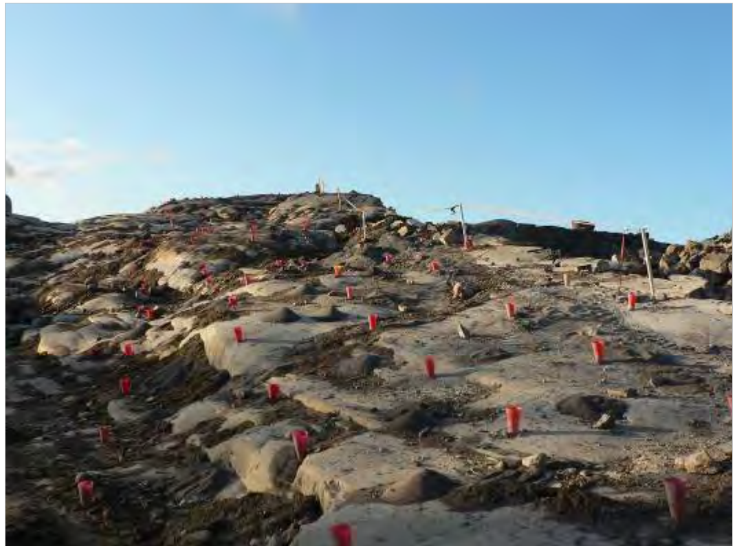
Kuva 3.5. Porattu räjäytyskenttä.
