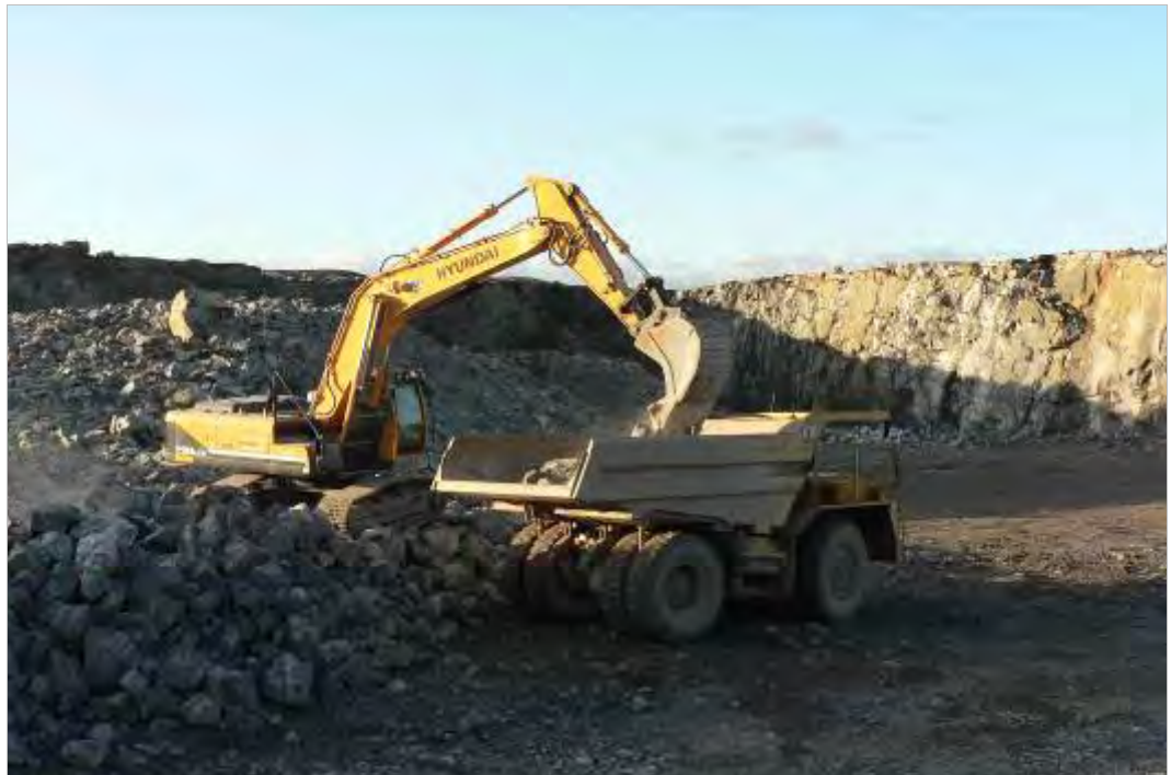
Kuva 3.6. Räjäytystöiden jälkeen louhe lastataan dumperiin, joka kuljettaa louheen murskauslaitokselle.
