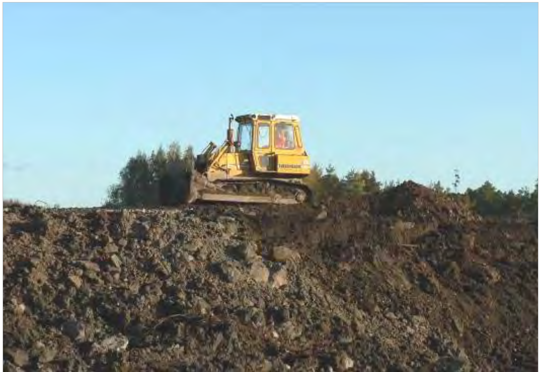
Kuva 3.10. Puskutraktoria käytetään ylijäämämassojen läjitystyöissä.
