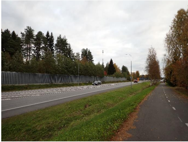
Kuva 33. Kuusamontie Kalimeenojan pohjoispuolella. Koilliseen.
