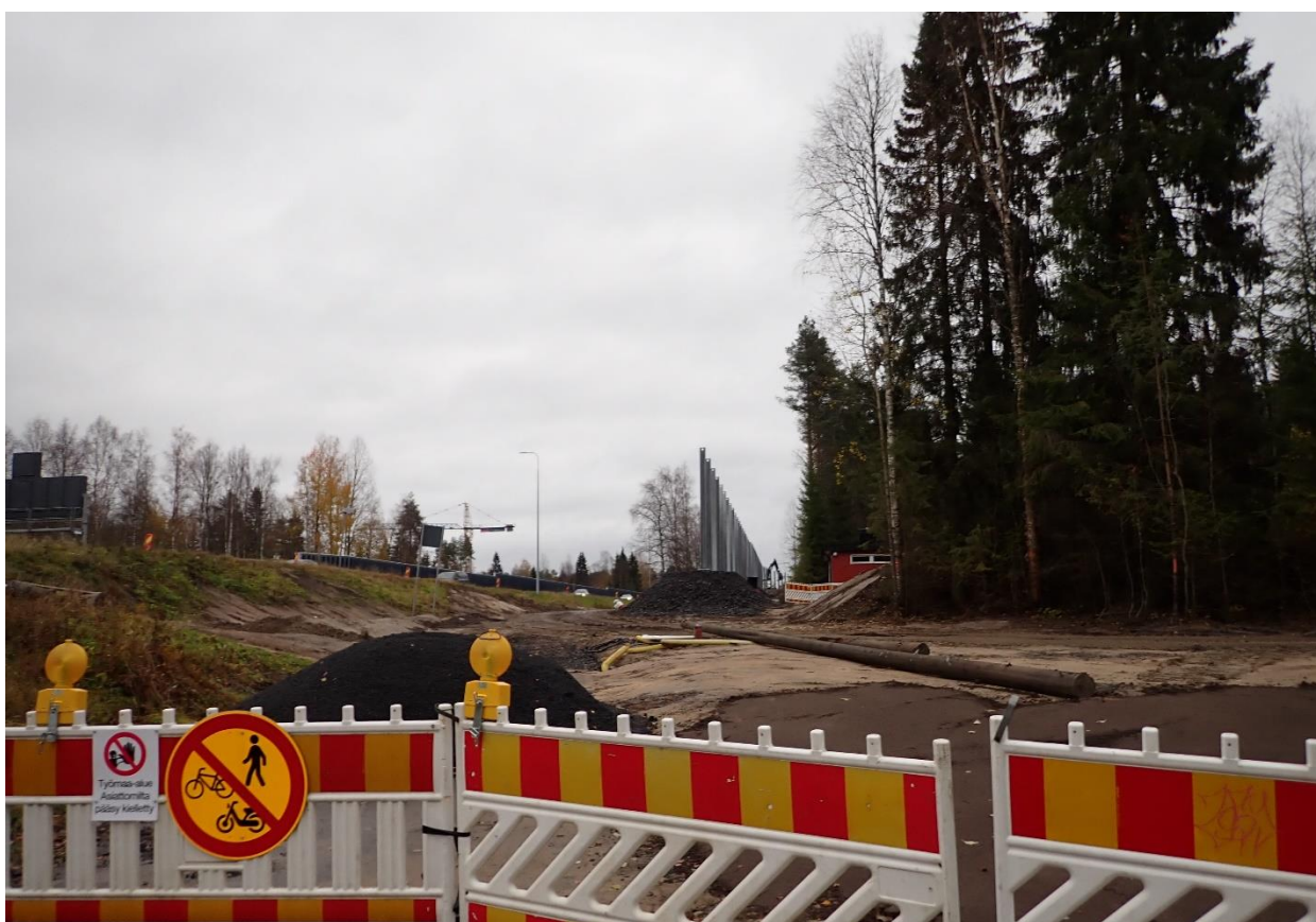
Kuva 19. Kuusamontien varressa oli kohteen kohdalla meluaidan rakennus kesken.
