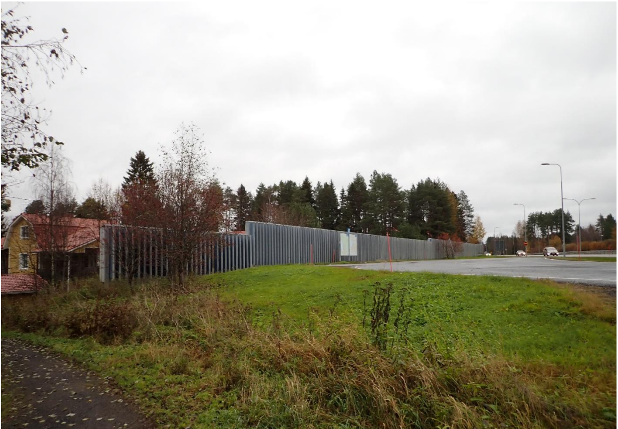
Kuva 15. Kohteen Oulu Korpelan vanha paikka sijainti kuvassa näkyvän rakennuksen pihapiirissä.
