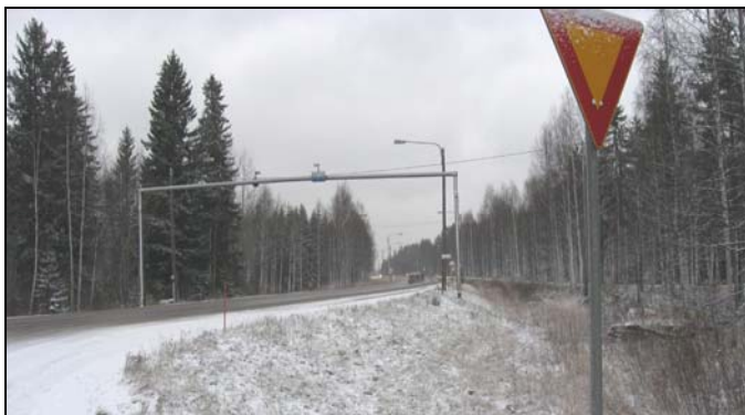
Kuva 54. Valtatie 5 Oravikoskentien liittymästä pohjoiseen. Portaalin kohdalla on kaukoliikenteen linja-autopysäkki pohjoissuuntaan.
