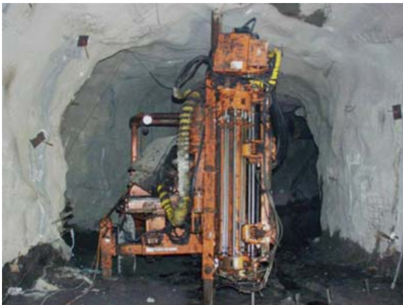
Kuva 8. Maanalaista louhintaporausta (Hituran kaivos).
