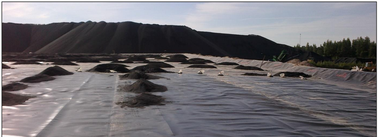
Kuva 5. Jätealueen pohjarakenteen rakentamista, kuvassa keinotekoisien eristeen asennusta. (Kuva: Lassila & Tikanoja Oyj)
