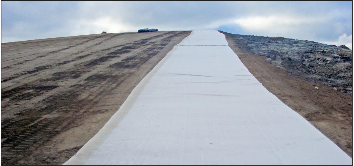
Kuva 7. Kaatopaikan pintarakenteen rakentamista. (Kuva: Lassila & Tikanoja Oyj)
