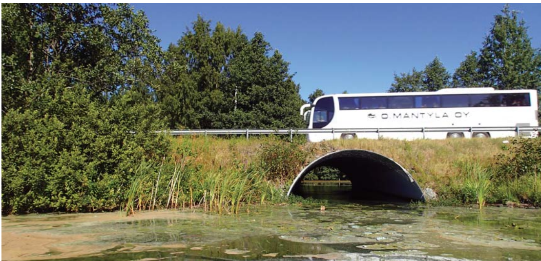
Kuva 3. Kirkkojärven ylittävän tien ali nykyisin menevä siltarumpu. Näkymä etelästä pohjoiseen.
