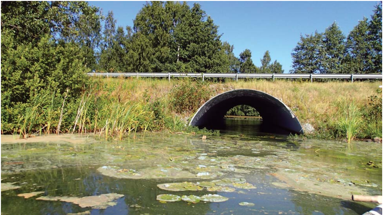
Kuva 12. Vt 12 alittava siltarumpu on nykyisin melko kapea ja estää takaisinvirtausta Kuohunlahteen.
