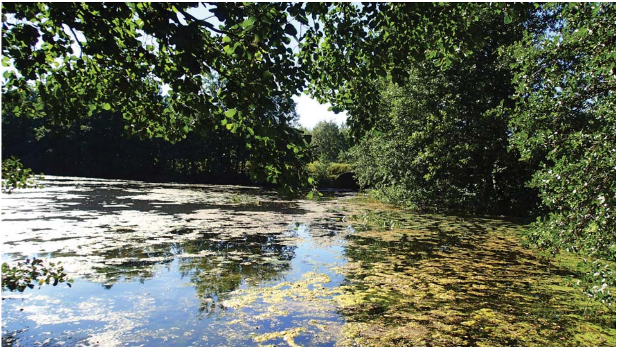
Kuva 10. Kuohunlahdenlounaispäässä on runsaasti pinnassa kelluvaa levää, mutta veden laatu kohtalaisen hyvä ja vesi kirkasta. Taustalla näkyy Vt 12:sta Kuohunlahden lounaispäässä alittava rumpu.
