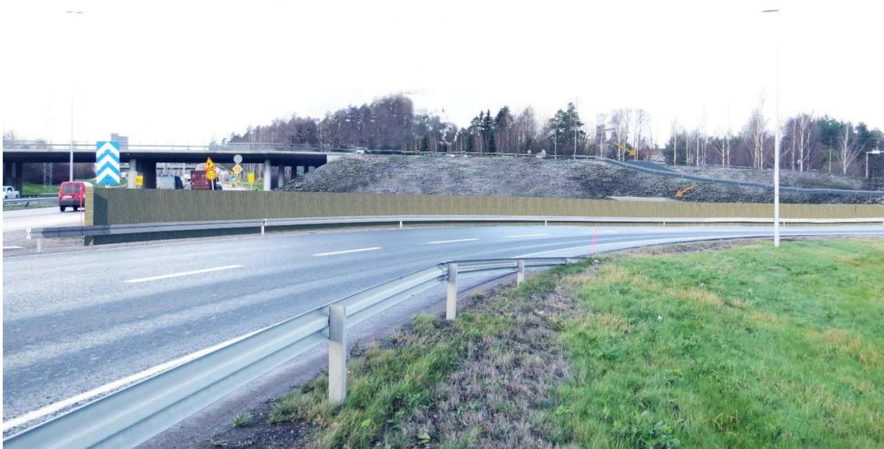
Kuva 7-37. Ylemmässä kuvassa on esitetty nykytilanne hankealueen kohdalta Kehä III:n liittymästä, hankealueen itäpuolelta katsottuna. Alemmassa kuvassa on kuvasovite, jossa on esitetty hankkeen edellyttämät rakenteet (tunnelin suuaukko ja ajoyhteys, osoitettu nuolella), sekä rakentamisen aikaiset näkemäestet (aidat). (AFRY 2021)
