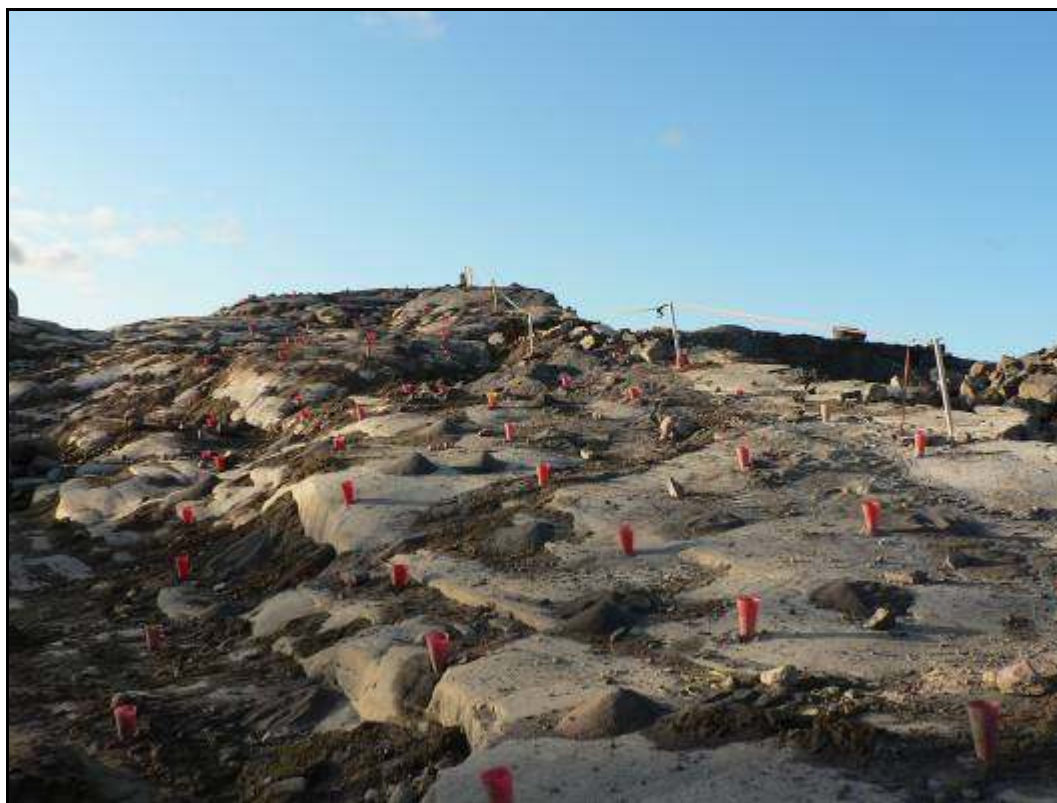
Kuva 7. Porattu räjäytyskenttä.
