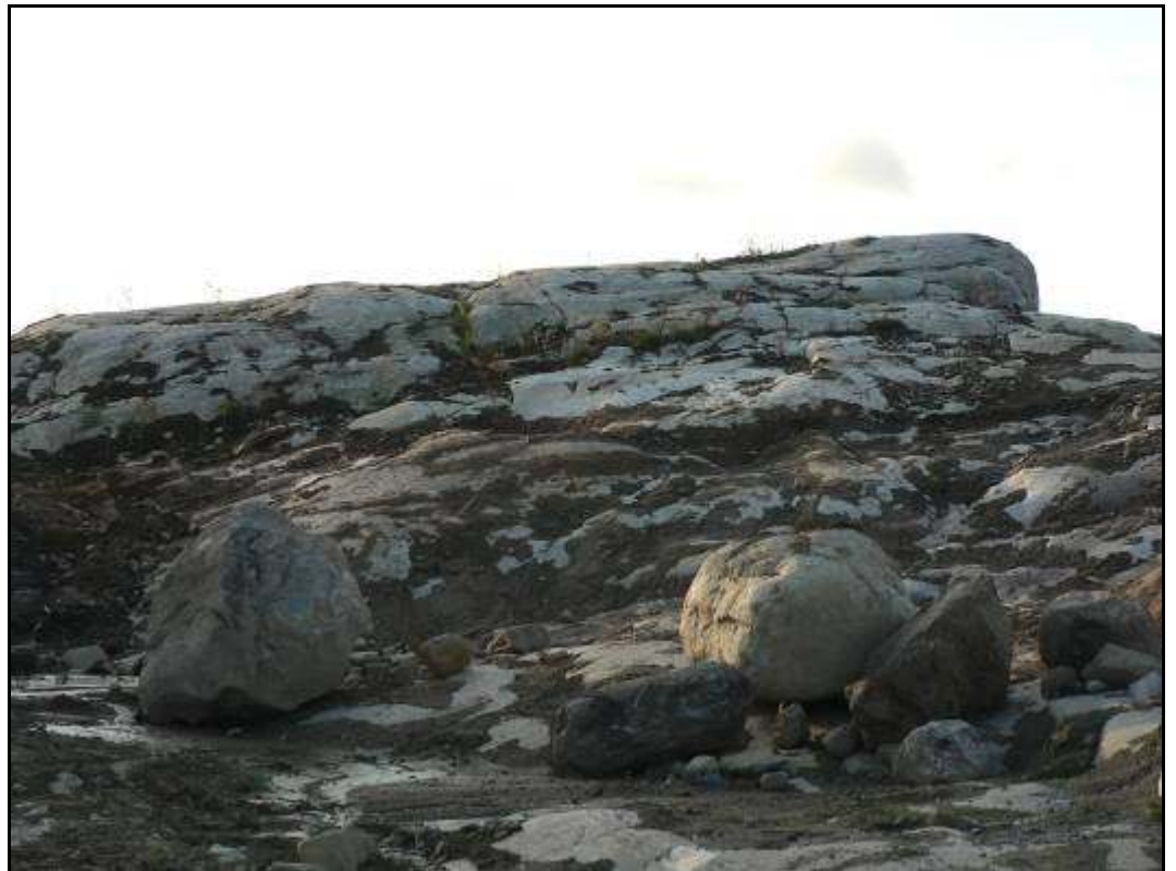
Kuva 6. Hankkeen alussa raivataan puusto ja pintamaat poistetaan. Kuvassa kalliopinta on "puhdistettu" louhintatöitä varten.
