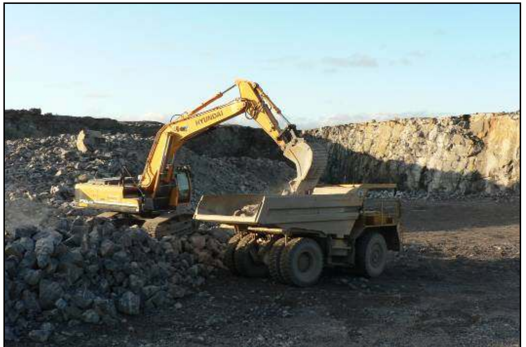
Kuva 8. Räjäytystöiden jälkeen louhe lastataan dumperiin, joka kuljettaa louheen murskauslaitokselle.
