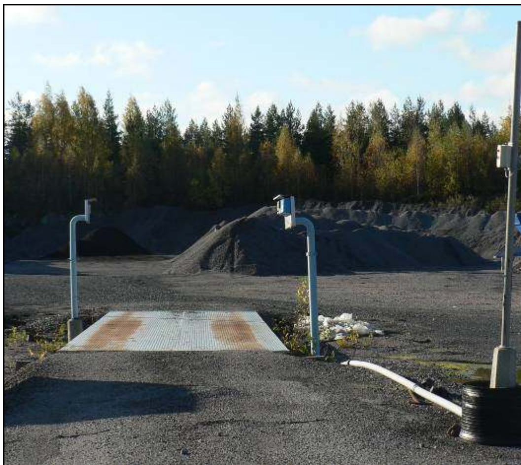
Kuva 11. Alueelle tulevat kuormat punnitaan sisääntuloportin yhteyteen rakennettavalla vaakasemalla.
