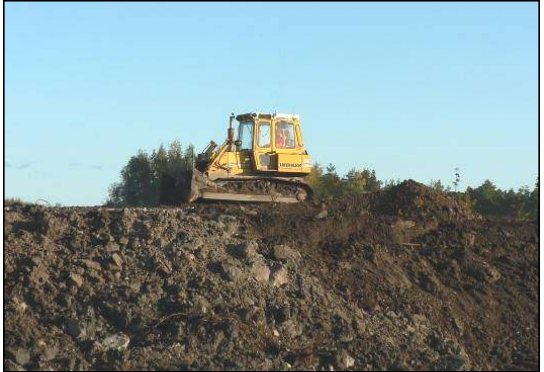
Kuva 12. Puskutraktori käytetään ylijäämämassojen läjitystöissä.
