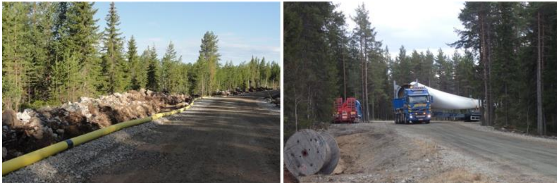
Bild 5.7 Till vänster ett exempel på byggnads- och servicevägar i vindkraftsparken. Till höger delar till vindkraftverk som transporteras som specialtransporter (FCG Finnish Consulting Group Oy).
