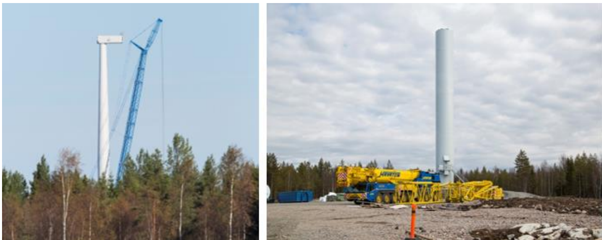
Bild 5.12 Montering av vindkraftverk (FCG Finnish Consulting Group Oy).
