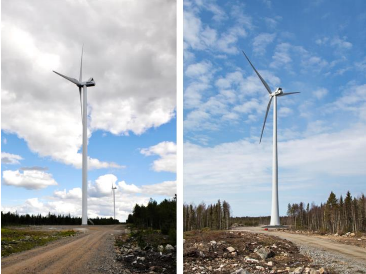
Bild 5.2 Till vänster ett exempel på ett stålcyndertorn och till höger ett hybridtorn (FCG Finnish Consulting Group Oy).
