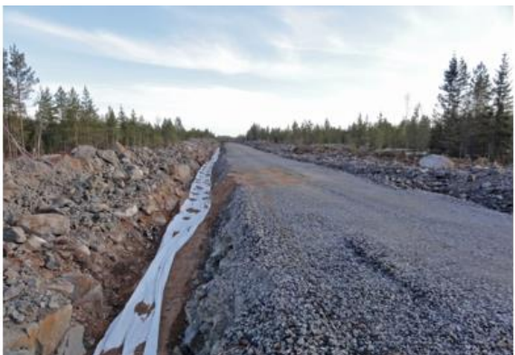
Bild 5.10 Jordkablar grävs ner i anslutning till servicevägarna (FCG Finnish Consulting Group Oy).
