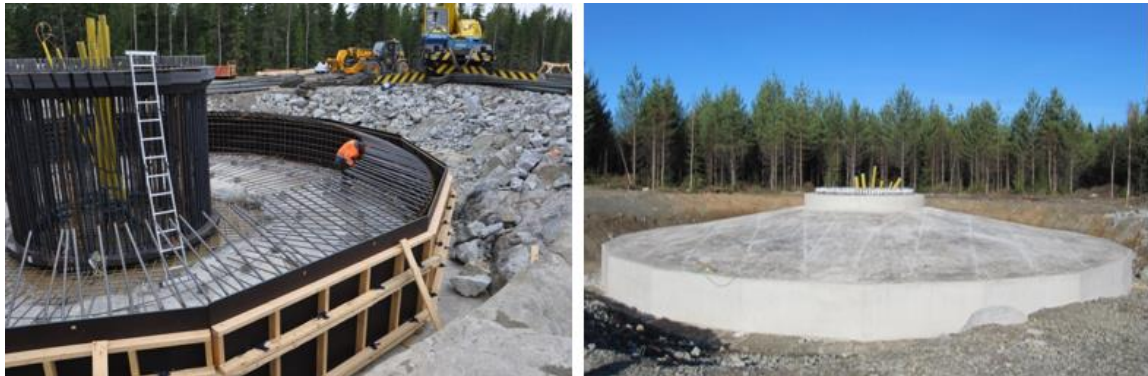
Bild 5.11 Byggande av fundament till vindkraftverk (FCG Finnish Consulting Group Oy).
