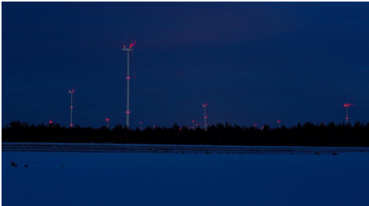
Bild 5.5 Röda kontinuerligt lysande flyghinderljus (FCG Finnish Consulting Group Oy).
