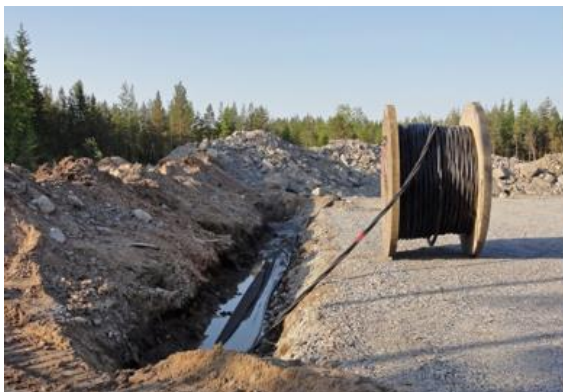
Bild 5.10 Jordkablar grävs ner i anslutning till servicevägarna (FCG Finnish Consulting Group Oy).
