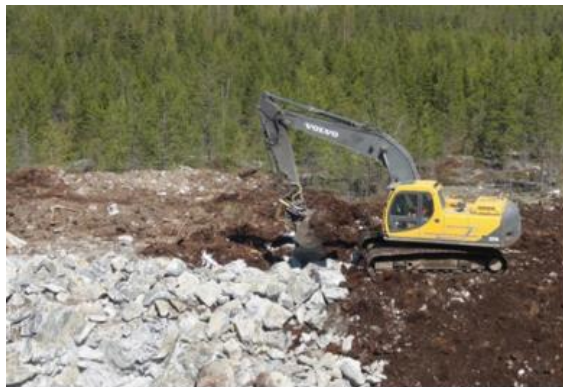
Bild 5.9 Byggandet av vindkraftsparken inleds med att bygga vägar och lyftområden (FCG, Finnish Consulting Group Oy).
