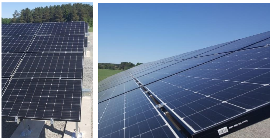
Kuva 3-4 Asennettuja aurinkopaneelitelineitä. © Naps Solar Systems.
