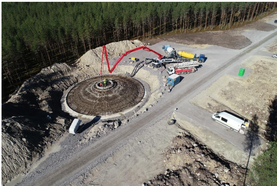
Kuva 3-13 Tuulivoimalan maanvaraisen perustuksen valamista. © Matti Latva-Hirvelä / Carelin Oy.
