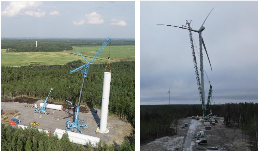
Kuva 3-17 Esimerkkejä tuulivoimaloiden pystytyksestä. © Matti Latva-Hirvelä / Carelin Oy.
