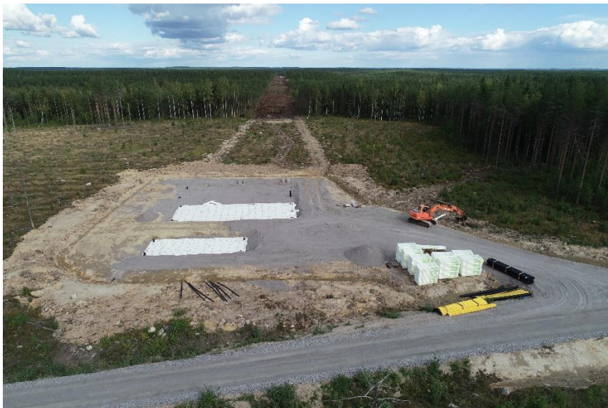
Kuva 3-15 Esimerkki tuulivoimapuiston sähköaseman pohjatöistä. Kuvassa myös hankkeen voimajohtokäytävä. © Matti Latva-Hirvelä / Carelin Oy.
