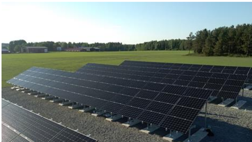
Kuva 3-19 Elementtiperustuksellisia aurinkopaneelitelineitä. © Naps Solar Systems.
