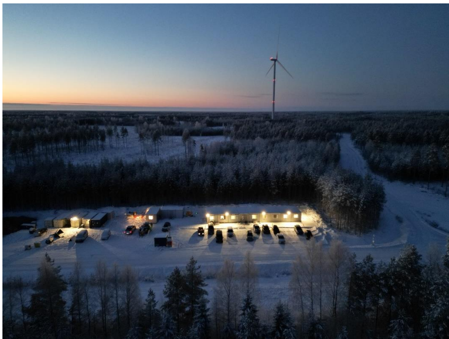
Kuva 3-9 Tuulivoimala-alueen työmaaparakkialue. © Matti Latva-Hirvelä / Carelin Oy.
