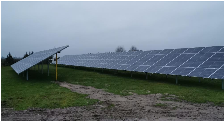
Kuva 3-18 Paaluperustuksellisia aurinkopaneelitelineitä. © Naps Solar Systems.
