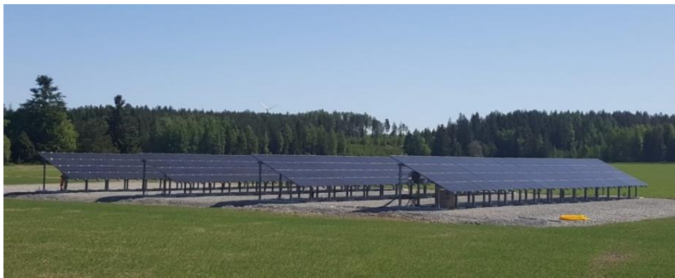
Kuva 3-3 Asennettuja aurinkopaneelitelineitä. © Naps Solar Systems.
