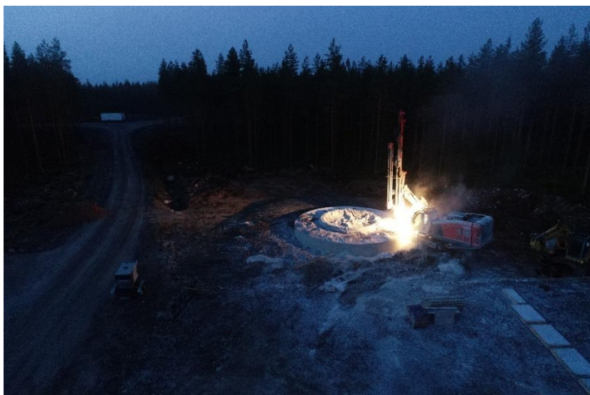
Kuva 3-14 Tuulivoimalan perustuksen kallioankkurin porausta. © Matti Latva-Hirvelä / Carelin Oy.
