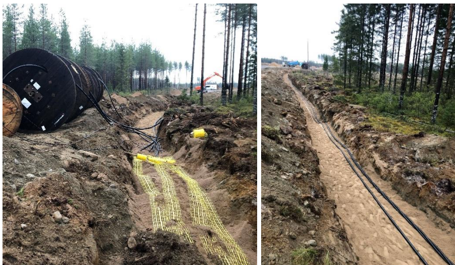
Kuva 3-5 Tuulivoimahankkeen maakaapelointia. © Matti Latva-Hirvelä / Carelin Oy.
