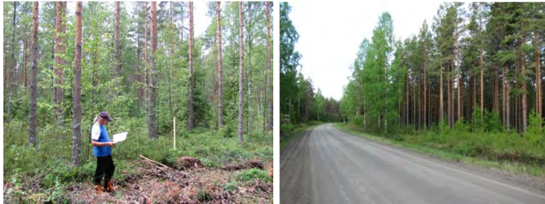
Kuva 65. Vasemmalla tuulivoimalan 1 rakentamisaluetta ja oikealla huoltotien liittymäkohta Uttermossantieltä (huoltotie lähtee kuvassa oikean eli lännen suuntaan).
