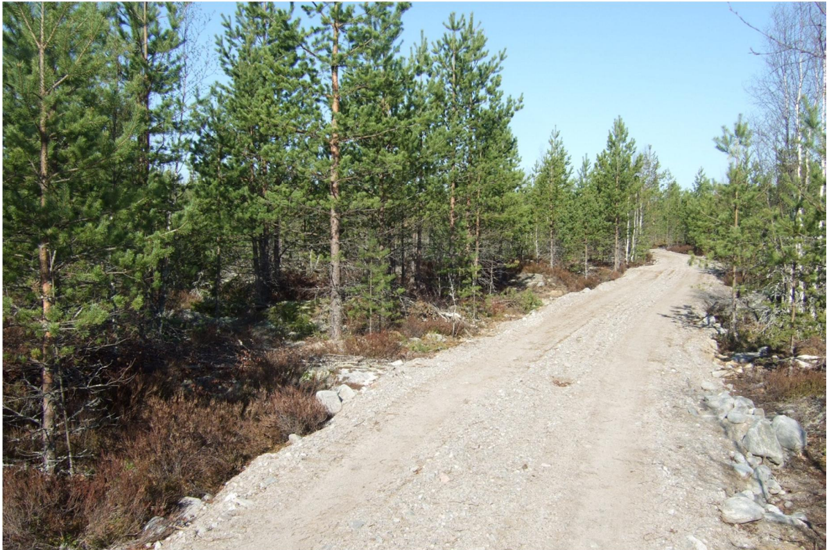
Kuva 32. Hankealueen olemassa olevia kulku-uria hyödynnetään perusparantamalla ne tuulivoimaloiden huoltoteiksi.
