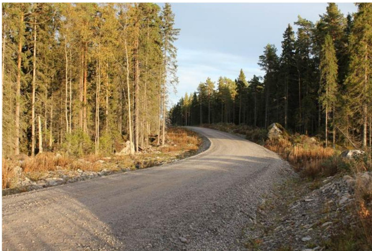
Kuva 17. Tuulivoimalan huoltotie – Öjen, Vaasa (Ramboll Finland Oy).
