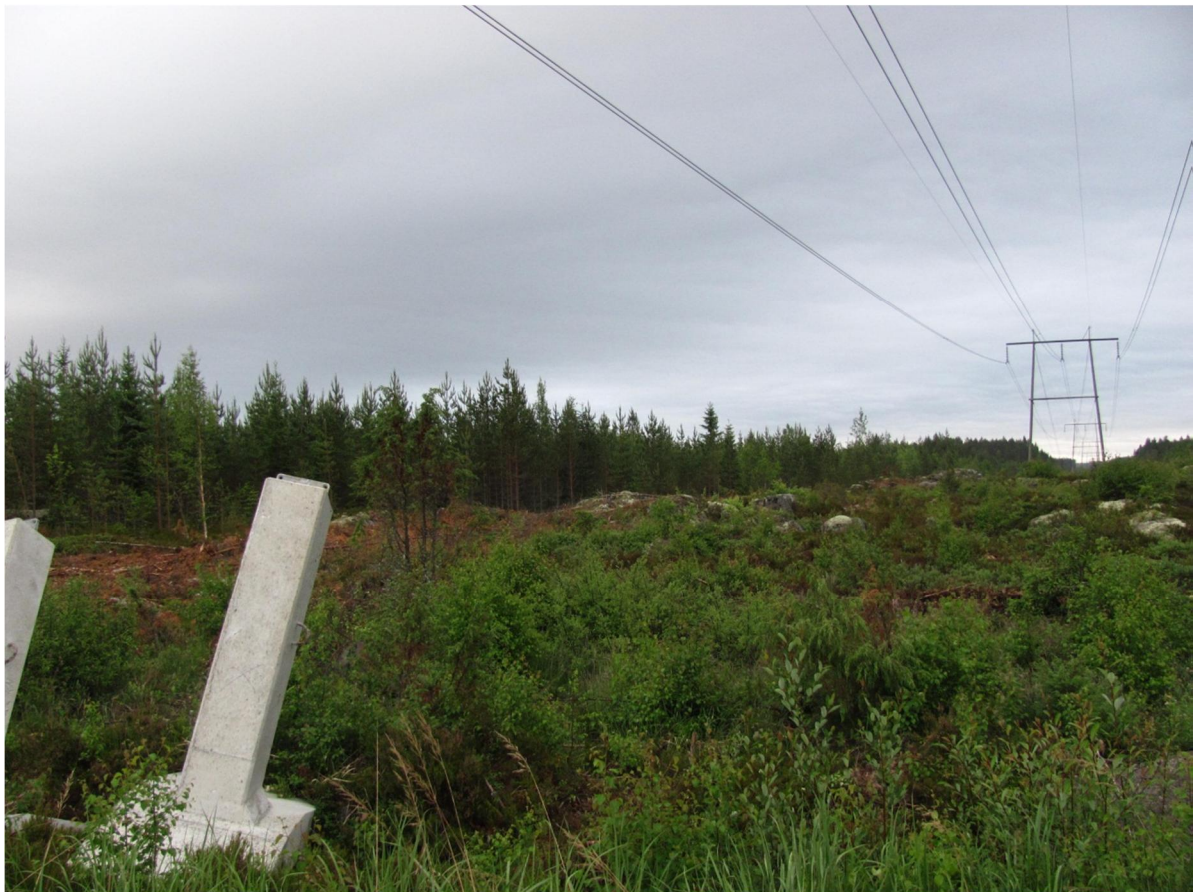
Kuva 8. Kristiina-Ulvila 220 kV voimajohdon varrella muutostyöt 400 kV voimajohdoksi olivat käynnissä kesällä 2013 Arkkukallion kohdalla.
