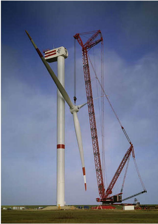
Kuva 19. Tuulivoimalan pystytys tela-alustaisella nosturilla (Liebherr 2012b).
