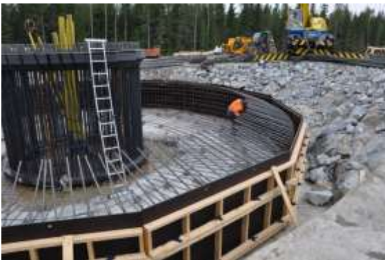
Kuvapari 4.11. Tuulivoimalan perustusten rakentamista. (Kuvat: Leila Väyrynen, FCG)
