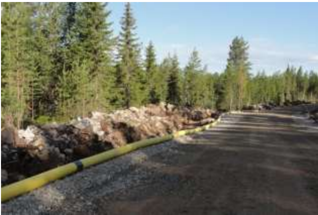
Kuva 4.6. (Vasemmalla) Esimerkki tuulivoimapuiston rakennus- ja huoltotiestä. Teitä käytetään muun muassa betonin, soran ja voimaloiden komponenttien kuljetuksiin sekä tuulivoimapuiston käyttövaiheessa huoltoajoihin. Maakaapeli sijoitetaan ojakaivantoon tien reuna-alueelle (Kuva: Ville Suorsa / FCG).
