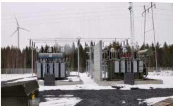
Kuvapari 4.12. Esimerkkikuvia tuulivoimapuiston 110/20 kV sähköasemasta. (Kuva: Leila Väyrynen/FCG).
