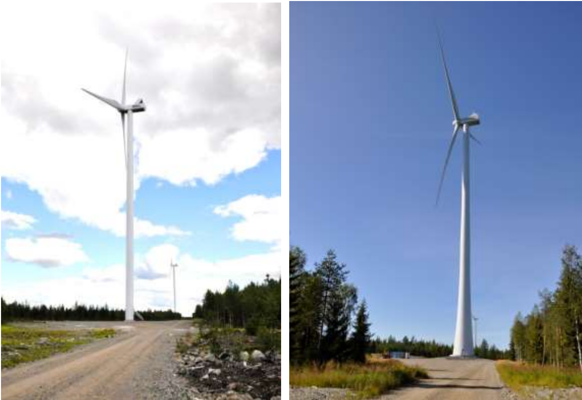
Kuva 4.1. Vasemmalla on esimerkki teräslieriötornista ja oikealla hybriditornista. (Kuvat: Leila Väyrynen, FCG)
