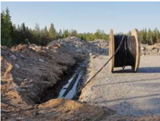
Kuvapari 4.10. Maakaapelit upotetaan huoltoteiden yhteyteen (kuvat: Ville Suorsa/FCG).
