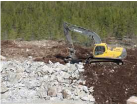
Kuvapari 4.9. Huoltoteiden ja pystytysalueiden rakentamista (kuvat: Ville Suorsa/FCG).
