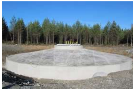
Kuvapari 4.11. Tuulivoimalan perustusten rakentamista. (Kuvat: Leila Väyrynen, FCG)
