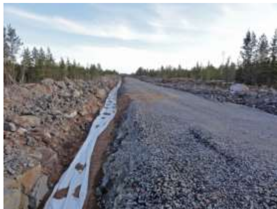
Kuvapari 4.10. Maakaapelit upotetaan huoltoteiden yhteyteen (kuvat: Ville Suorsa/FCG).
