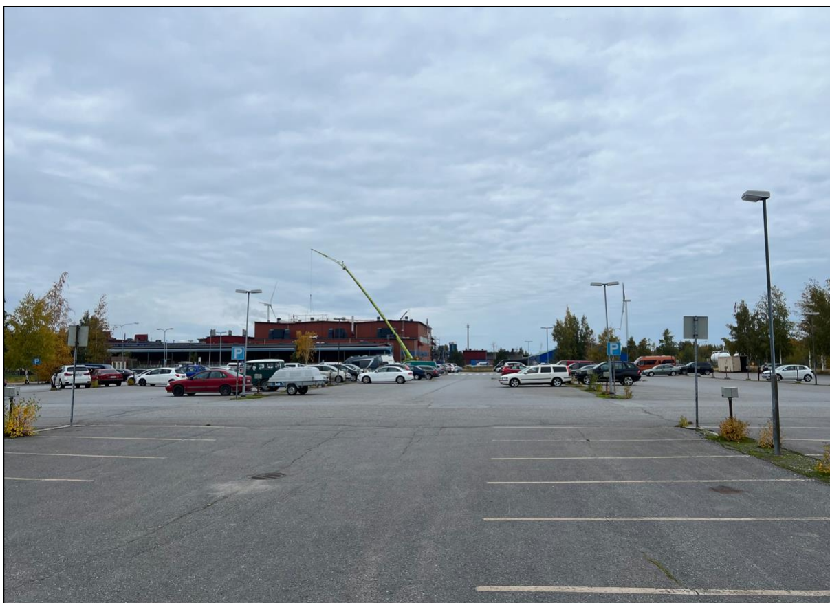
Kuva 159. Eteläinen laajennusalue kuvattuna P2-parkkipaikalta tulevan jätevedenpuhdistamon suuntaan.
