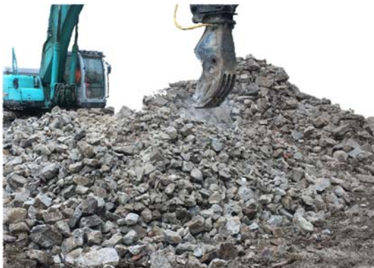
Kuva 6 Betonijätteen pulverointia
