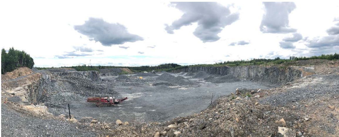
Kuva 15 Rudus Oy Takamaan maa-ainesten ottoalue (kuvaussuunta kaakkoon)
