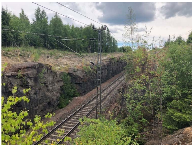
Kuva 25 Tampere- Seinäjoki rautatie hankealueen kohdalla
