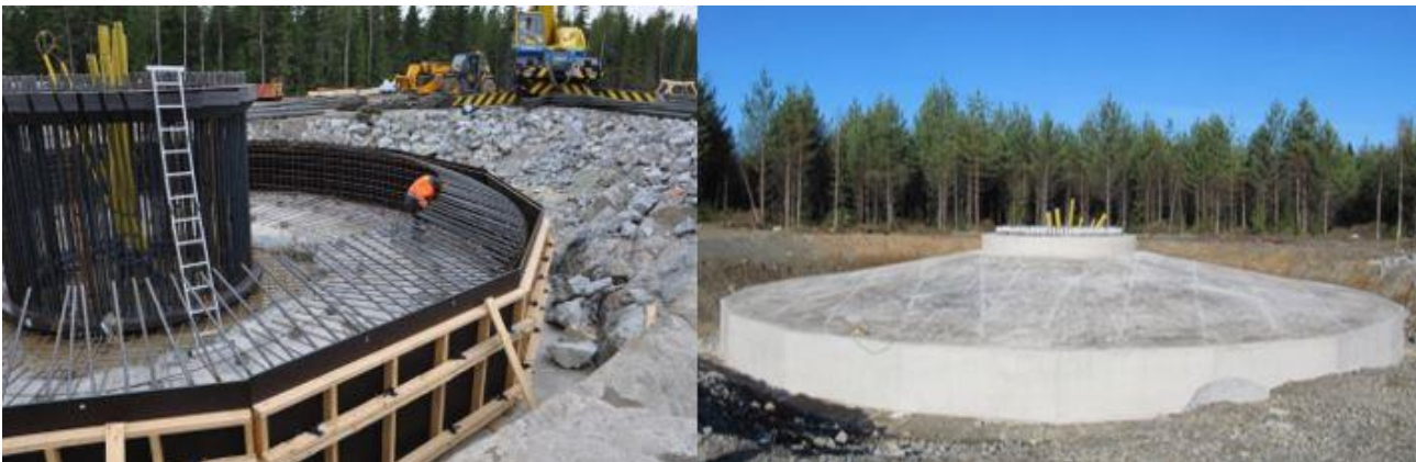
Kuva 5-11. Tuulivoimalan perustusten rakentamista (Leila Väyrynen, FCG).
