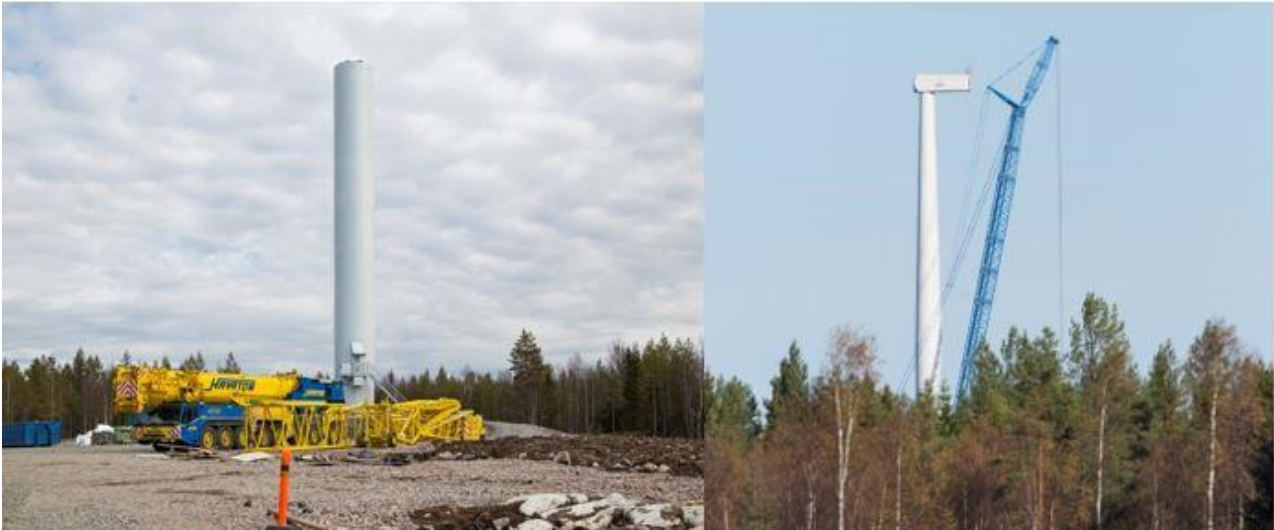
Kuva 5-12. Tuulivoimalan kokoamista (Ville Suorsa, FCG).
