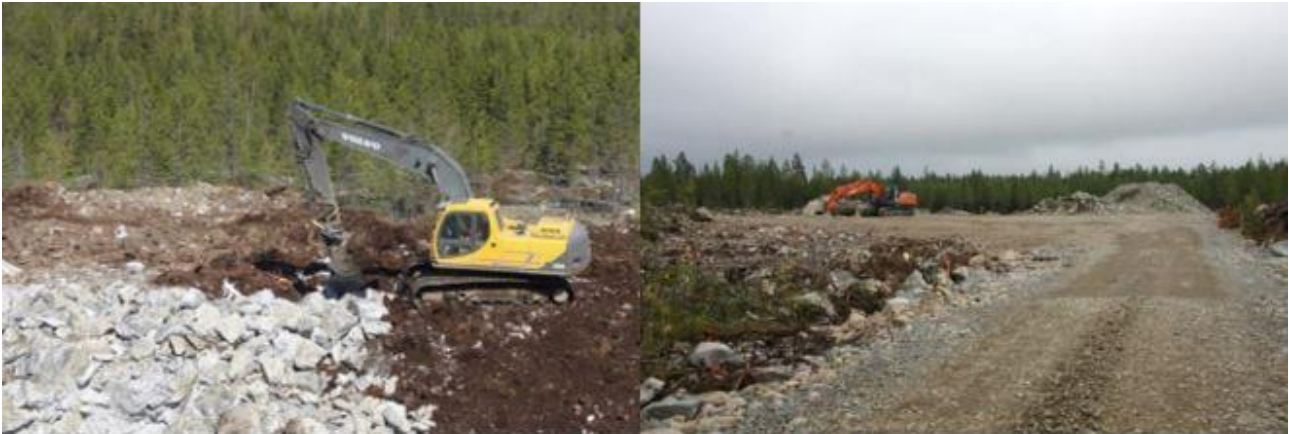
Kuva 5-9. Tuulivoimapuiston rakentaminen alkaa huoltoteiden ja pystytysalueiden rakentamisella (Ville Suorsa, FCG).
