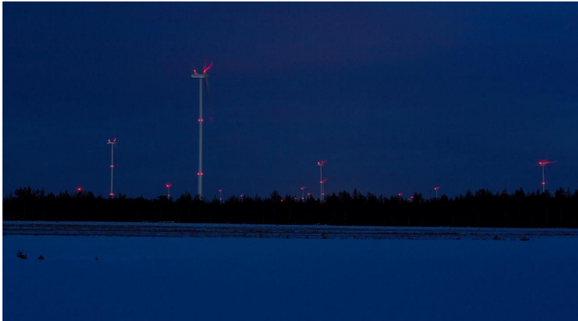
Kuva 5-5. Kiinteät punaiset lentoestevalot (Ville Suorsa, FCG).
