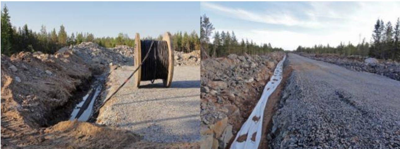
Kuva 5-10. Maakaapelit upotetaan huoltoteiden yhteyteen (Ville Suorsa, FCG).
