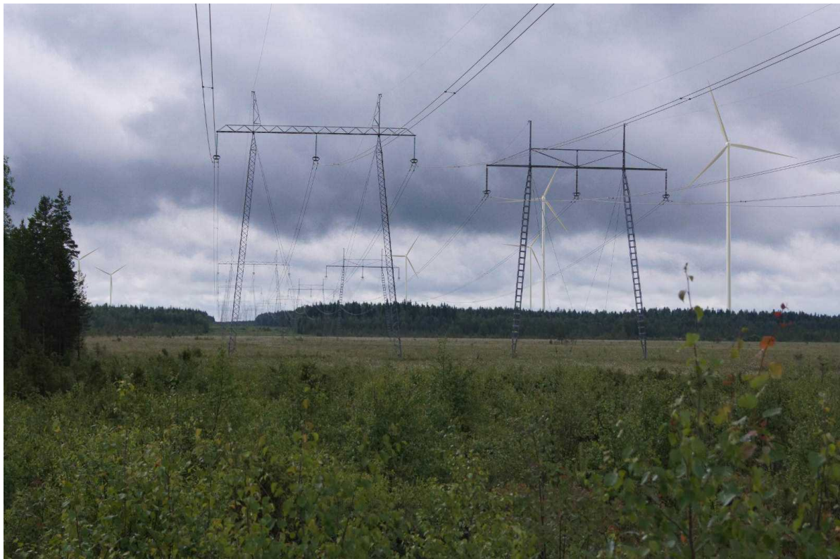
Kuva 53. Havainnekuva Lestijärven Pikkuradantieltä Paukanevan itäosasta lounaaseen kohti Lestijärven puoleista hankealuetta (VE1). Kameran polttoväli on 55mm. Etäisyyttä lähimpiin kuvassa näkyviin voimaloihin on 1,7 km.
