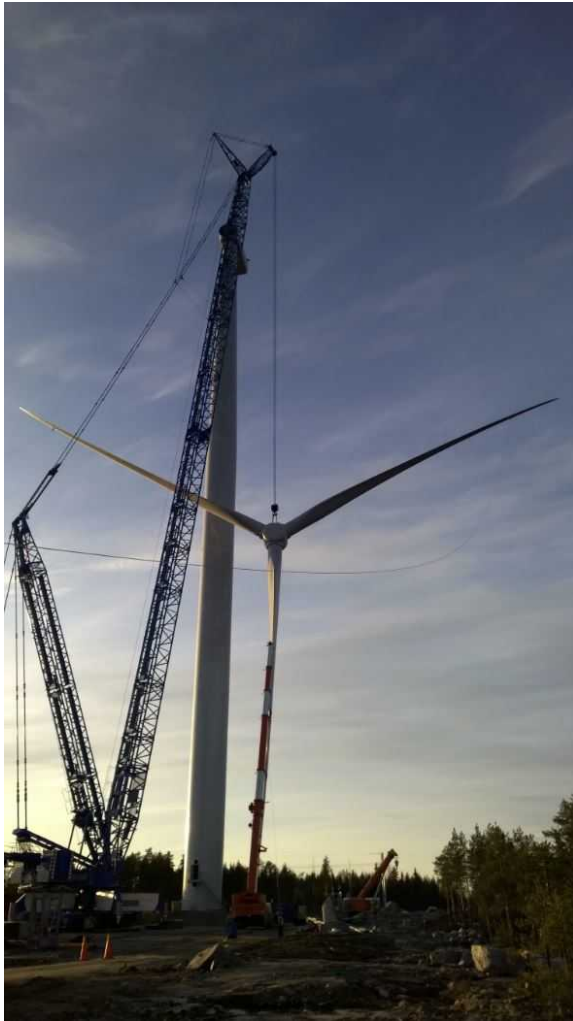
Kuva 15. Tuulivoimalan pystytystä Mäkikankaan tuulipuistossa Pyhäjoella. © wpd Finland Oy.
