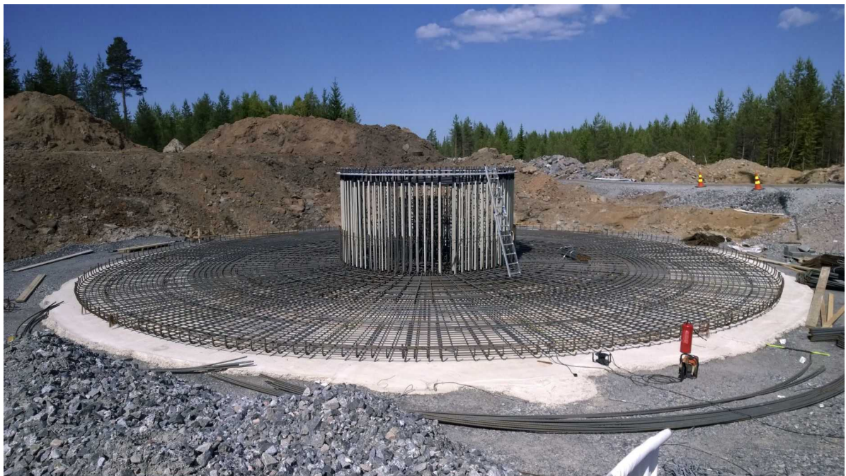
Kuva 10. Maanvarainen teräsbetoniperustus raudoitettuna ennen betonivalua, Mäkikankaan tuulipuisto Pyhäjoki © wpd Finland Oy.
