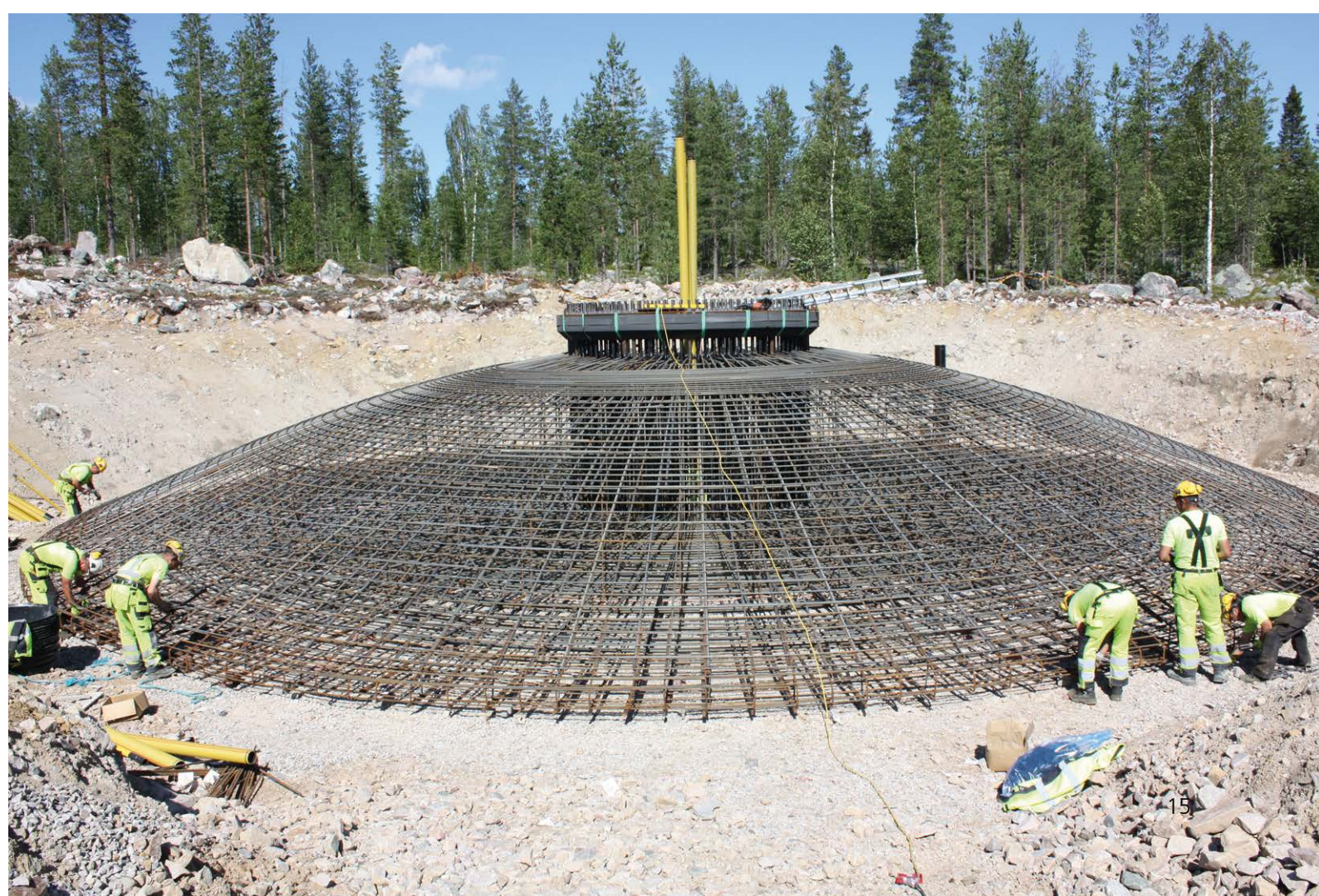
Figur 4-5. Gravitationsfundament av stålbetong, armerat före betonggjutningen, Tervola.
