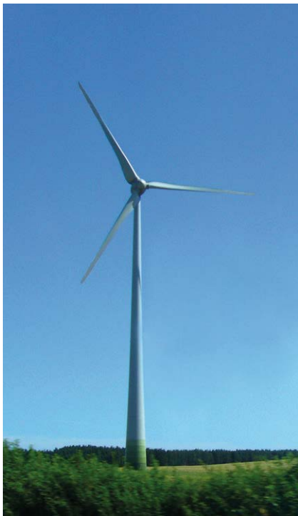
Figur 4-3. Bild av ett vindkraftverk med cylinderformad tornkonstruktion.
