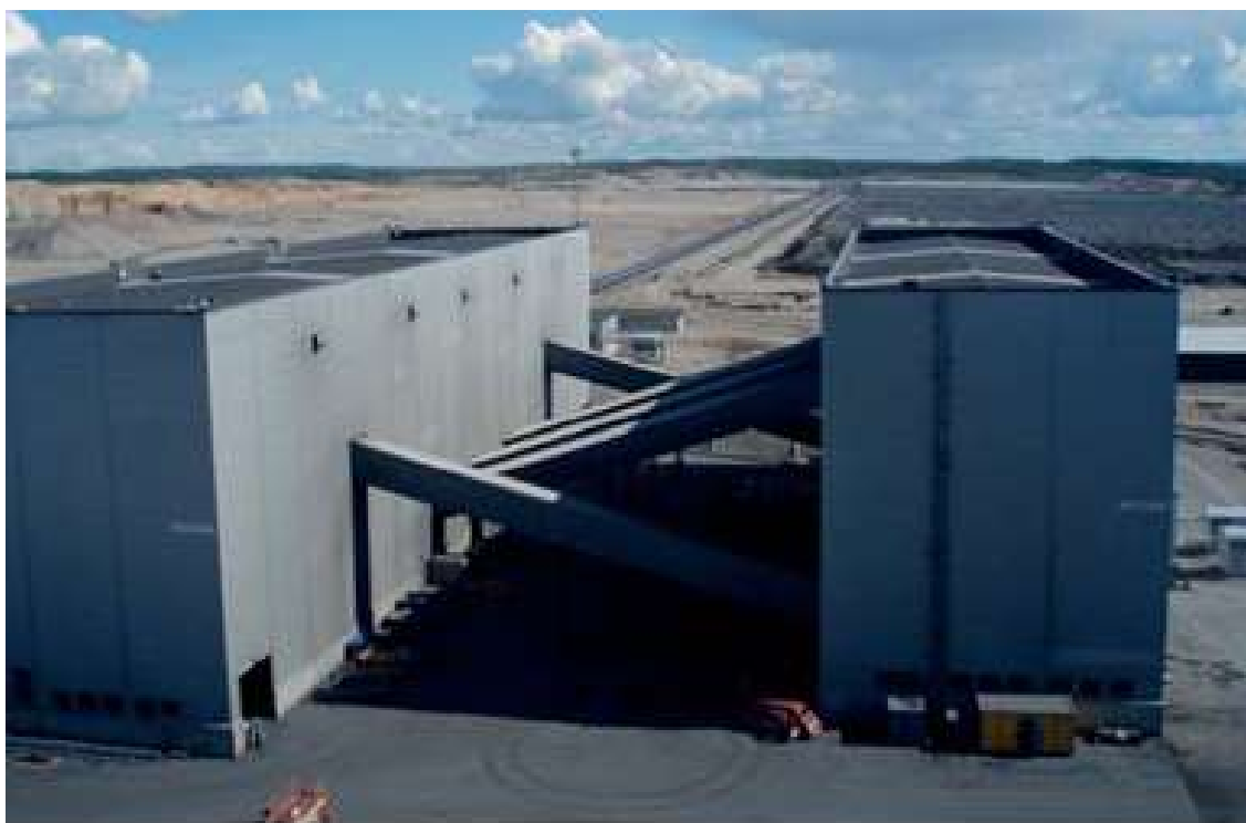
Kuva 4-6. Seulonta ja hienomurskaamo (Ramboll Finland Oy 2012).
