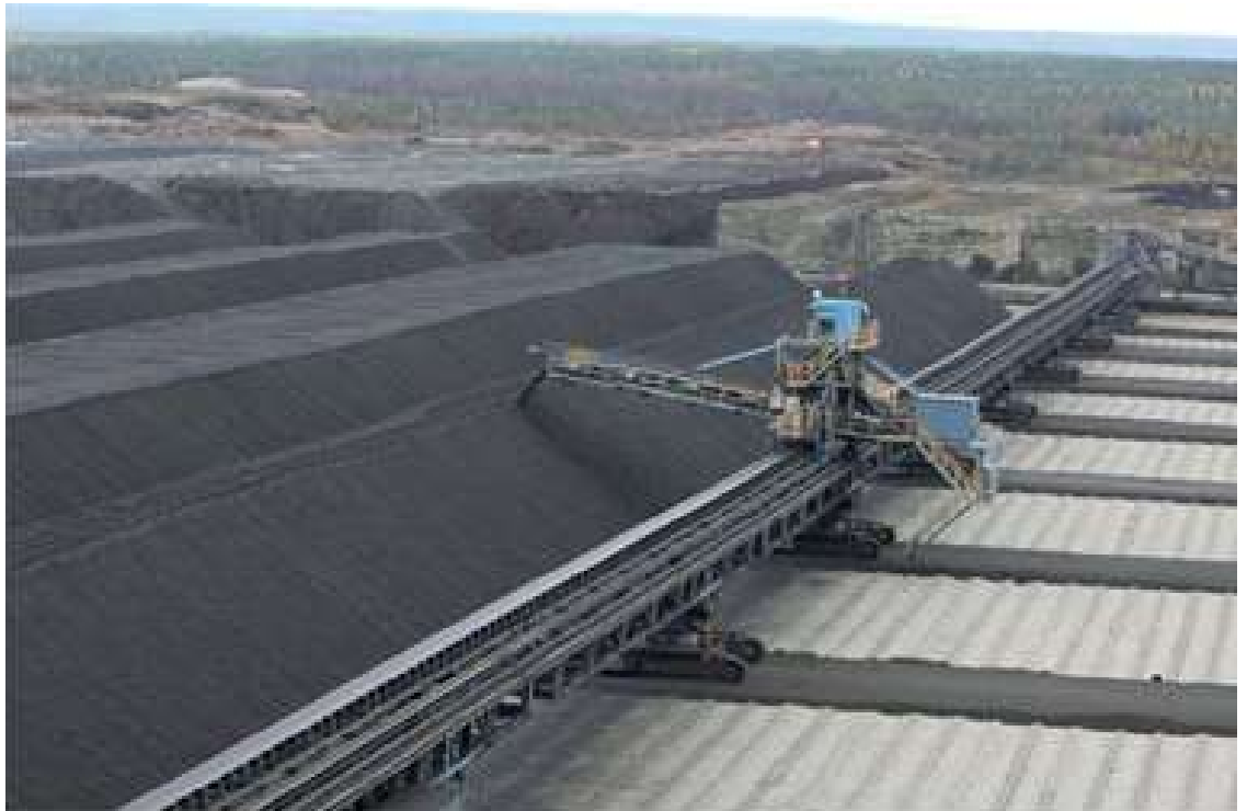
Kuva 4-7. Primääriliuotuskasan täyttö sähkökäyttöisellä kasauslaitteistolla (ns. stakkerilla) (Ramboll Finland Oy 2012).
