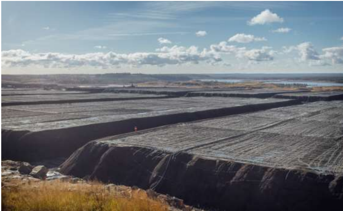
Kuva 4-8. Primääriliuotusalue (Terrafame 2015). Yhden kentän koko 400 m x 1 200 m ja malmikerroksen korkeus 7...10 m.
