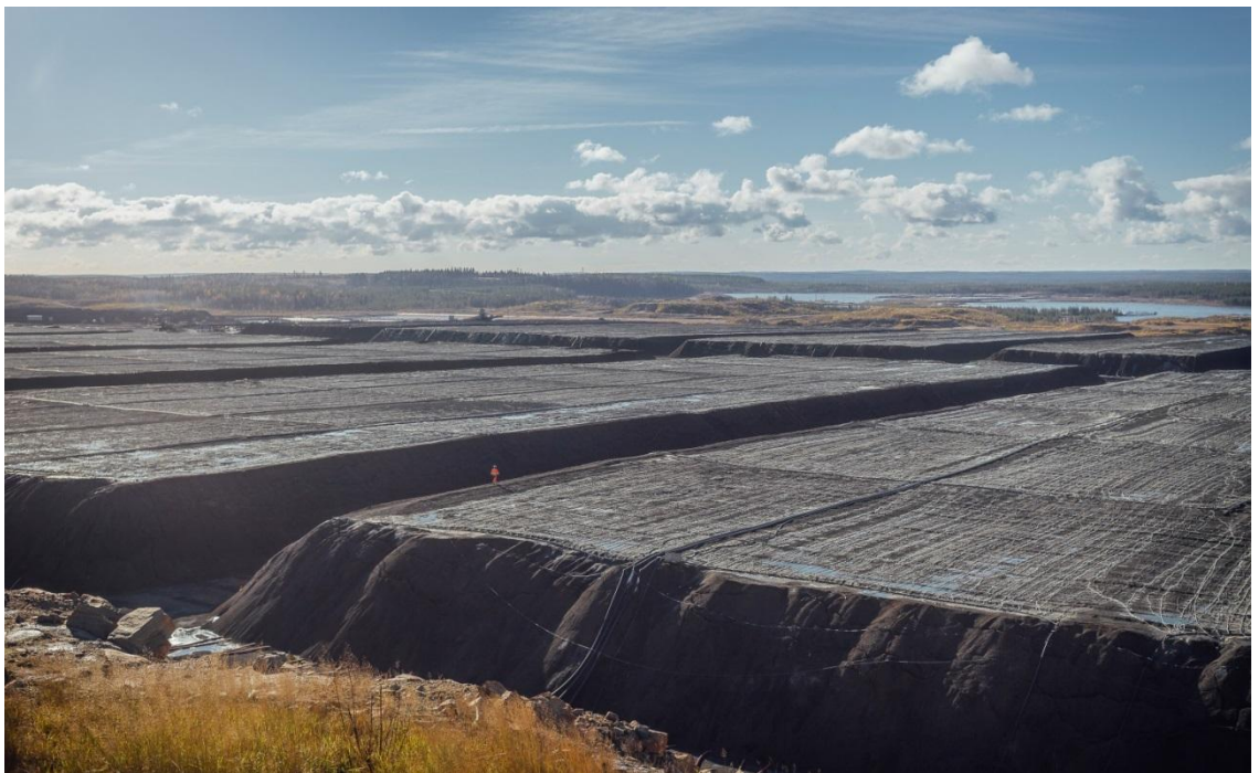
Kuva 3-8. Primääriliuotusalue (Terrafame 2015). Yhden kentän koko 400 m x 1 200 m ja malmikerroksen korkeus 6...12 m.
