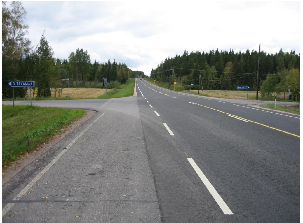
Kuva 15. Takamaantien liittymänäkymä Turun suuntaan (AIRIX Ympäristö Oy, 2011).
