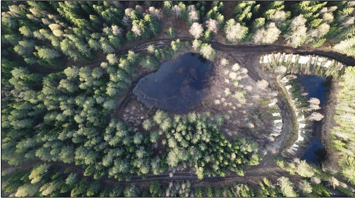
Kuva 7. Kaivetut sammakkolammet ylhäältä päin (isomman lammen ympärillä näkyy ajouria ja puujätteitä, oikealla varastopuukasoja).
