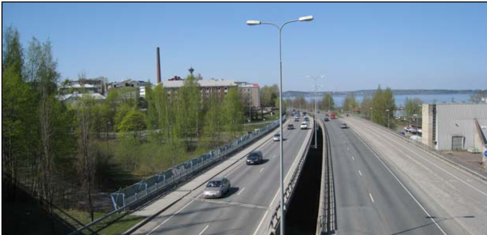
Kuva 10. Rantaväylä Armonkallion ja Naistenlahden voimalaitoksen kohdalla.
