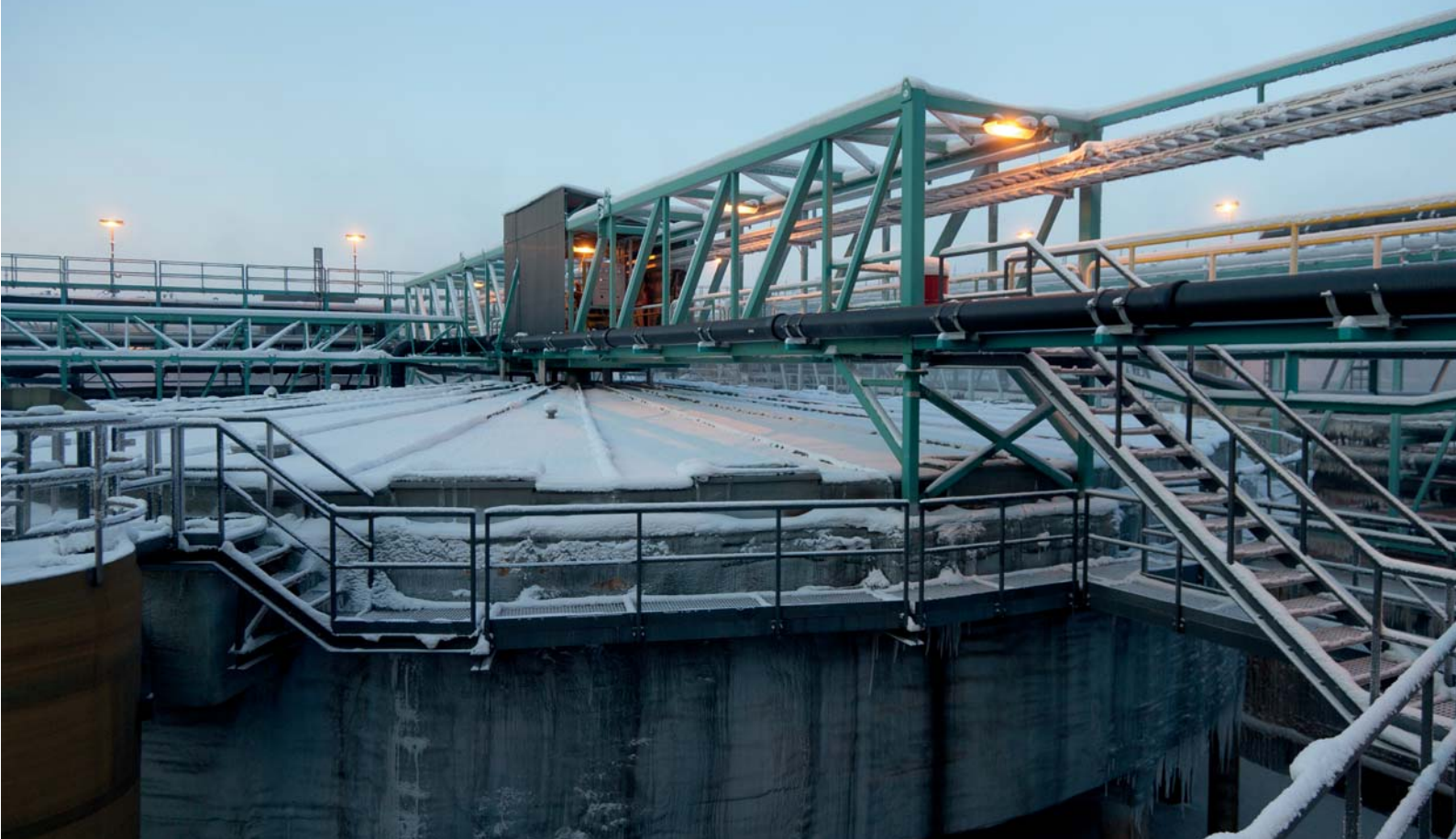
Kuva 2-17. Sakeutin metallien talteenottolaitoksella.
