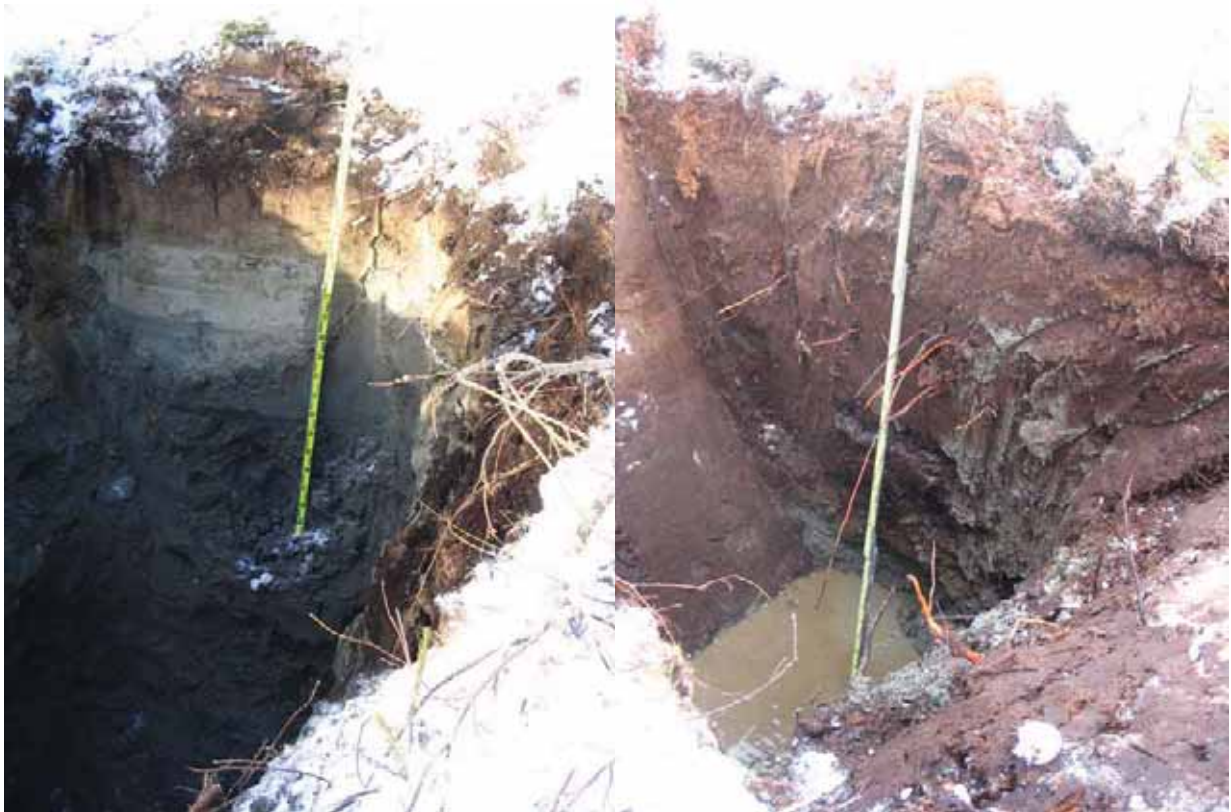
Kuva 4. Kuvassa vasemmalla moreeniin kaivettu koekuoppa, jossa pinnalla silttikerros. Oikealla turvealueen koekuoppa.
