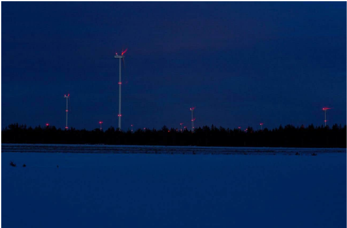
Kuva 4.1.5. Kiinteät punaiset lentoestevalot. (Kuva: FCG)
