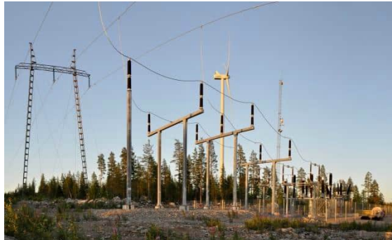
Kuvapari 4.3.5. Esimerkkikuvia tuulivoimapaiston 110/20 kV sähköasemasta. (Kuvat: Leila Väyrynen, FCG).
