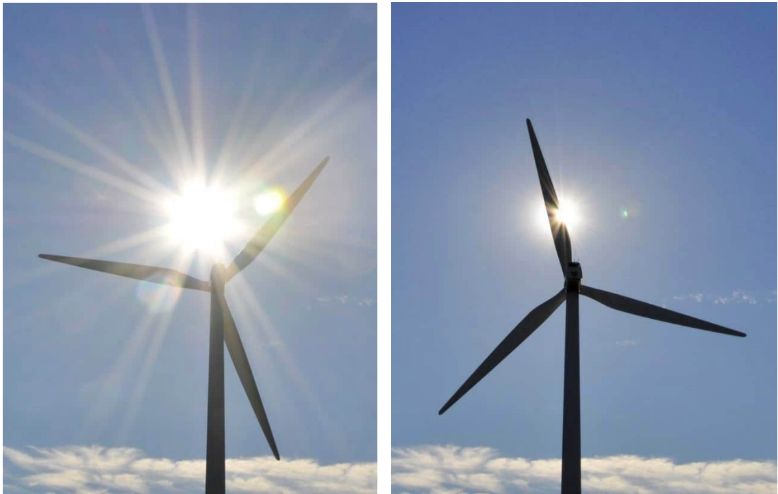
Kuva 8.10.11. Tuulivoimaloiden lavat aiheuttavat pyöriessään vilkkumista ja varjon välkkymistä aurinkoisella säällä.
