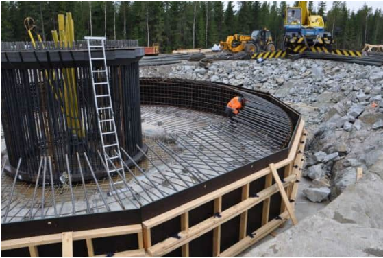
Kuvapari 4.3.4. Tuulivoimalan perustusten rakentamista. (Kuvat: Leila Väyrynen, FCG)
