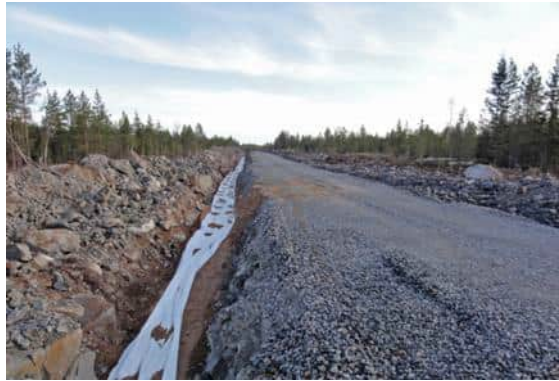
Kuvapari 4.3.3. Maakaapelit upotetaan huoltoteiden yhteyteen (kuvat: FCG).
