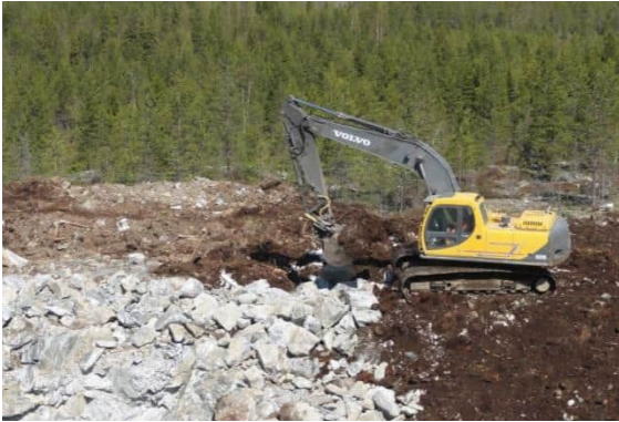
Kuvapari 4.3.2. Huoltoteiden ja pystytysalueiden rakentamista (kuvat: FCG).
