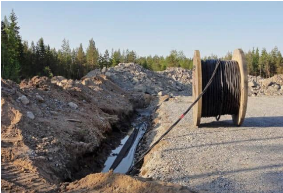
Kuvapari 4.3.3. Maakaapelit upotetaan huoltoteiden yhteyteen (kuvat: FCG).
