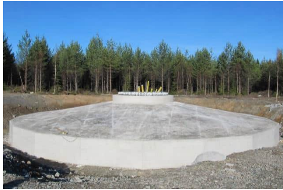
Kuvapari 4.3.4. Tuulivoimalan perustusten rakentamista. (Kuvat: Leila Väyrynen, FCG)
