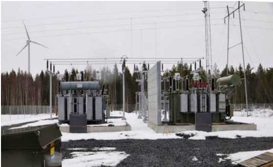
Kuvapari 4.3.5. Esimerkkikuvia tuulivoimapaiston 110/20 kV sähköasemasta. (Kuvat: Leila Väyrynen, FCG).
