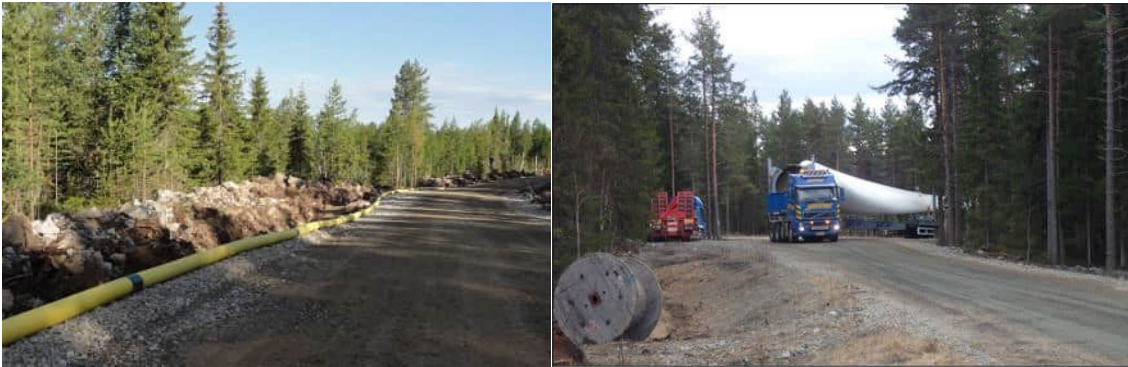
Kuva 4.1.8. (Vasemmalla) Esimerkki tuulivoimapuiston rakennus- ja huoltotiestä. Teitä käytetään muun muassa betonin, soran ja voimaloiden komponenttien kuljetuksiin sekä tuulivoimapuiston käyttövaiheessa huoltoajoihin. Maakaapeli sijoitetaan ojakaivautoon tien reuna-alueelle. (Oikealla) Tuulivoimalan osia kuljetetaan erikoiskuljetuksina. (Kuvat: FCG).
