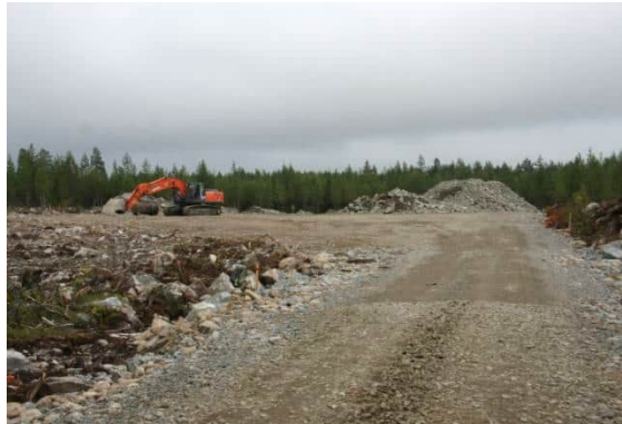
Kuvapari 4.3.2. Huoltoteiden ja pystytysalueiden rakentamista (kuvat: FCG).
