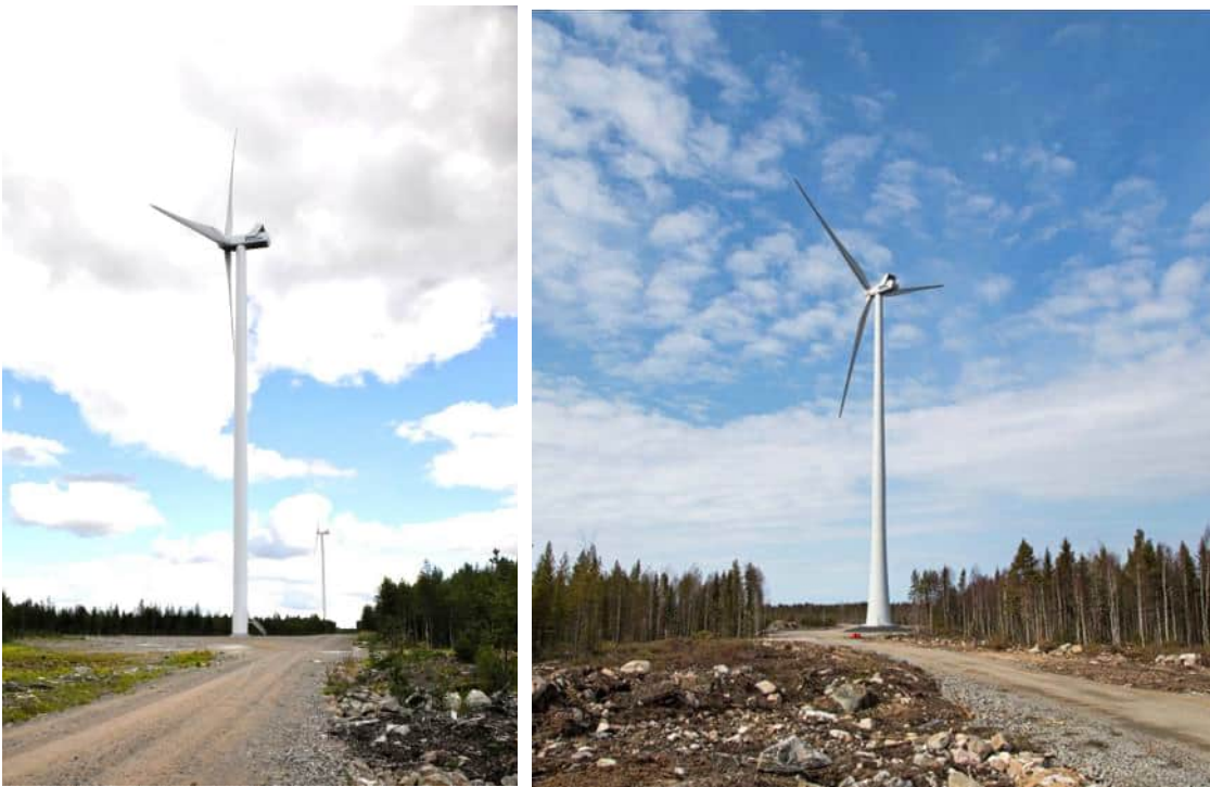
Kuva 4.1.2. Vasemmallalla on esimerkki teräslieriötornista ja oikealla hybriditornista. (Kuvat: FCG)
