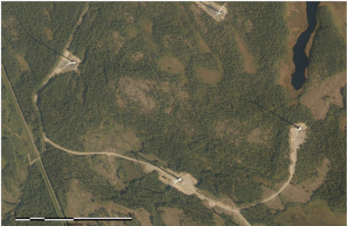
Kuva 4.1.1. Esimerkki-ilmakuvassa näkyy toiminnassa olevia tuulivoimaloita. Tuulivoimaloita varten on rakennettu huoltotiet ja nostokentät. Tuulivoimaloiden ympäristössä ja väli-alueilla maankäyttö on säilynyt ennallaan.
