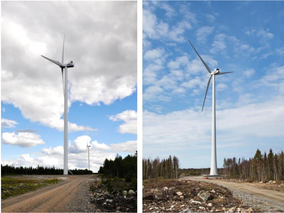
Kuva 4.3. Vasemmalla on esimerkki teräslieriötornista ja oikealla hybriditornista (FCG Finnish Consulting Group Oy).
