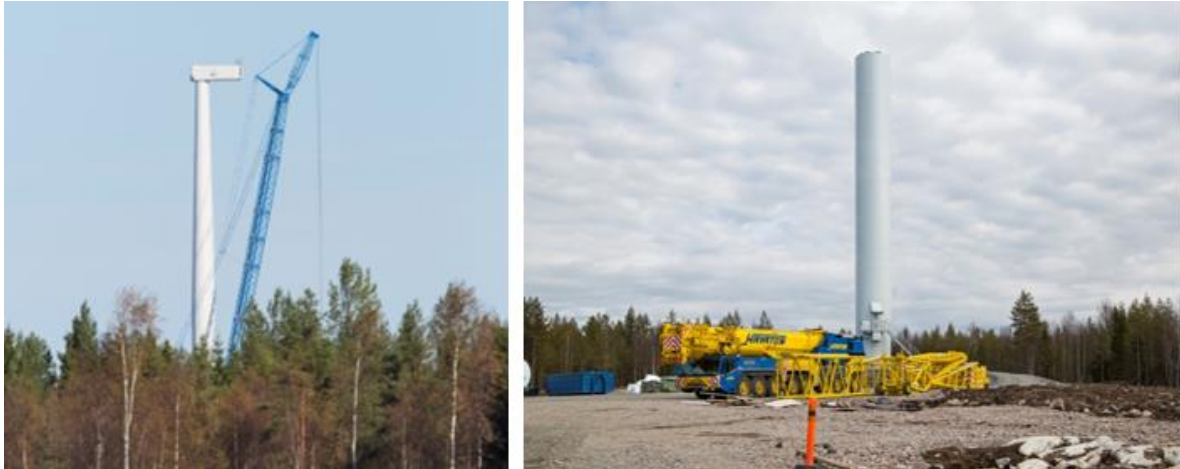
Kuva 4.15 Tuulivoimalan kokoamista (FCG Finnish Consulting Group Oy).
