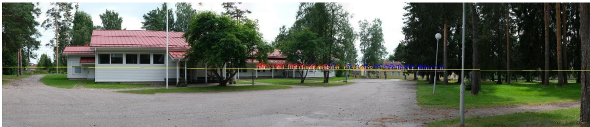
Kuva 8.24. Havainnekuva kuvauspisteestä 2 Rantsilan kirkko. Taikkonevan voimaloiden roottorit ympyröity punaisella (VE1), Leuvanvevan voimaloiden roottorit sinisellä ja
