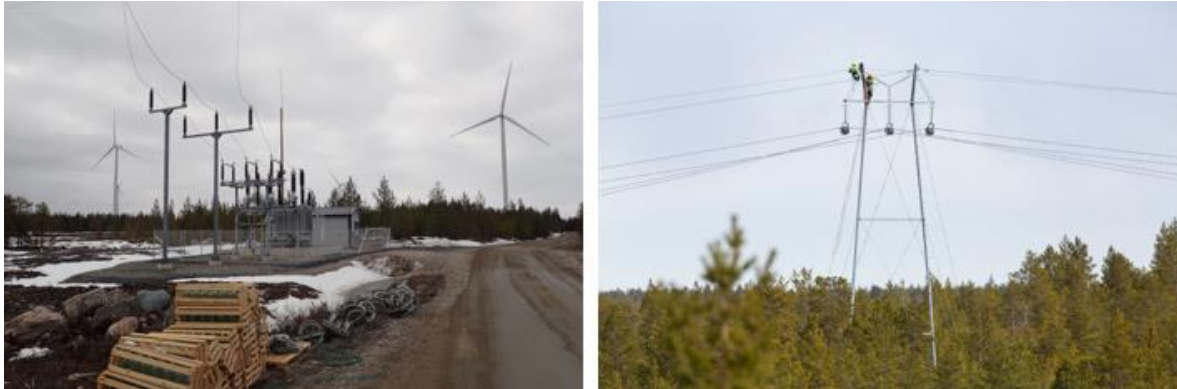
Kuva 4.17 Sähköaseman ja voimajohton rakentamista (FCG Finnish Consulting Group Oy).
