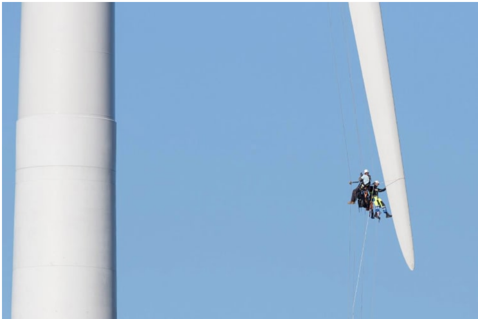
Kuva 4.19 Tuulivoimalan huoltotoimenpiteitä (FCG Finnish Consulting Group Oy).
