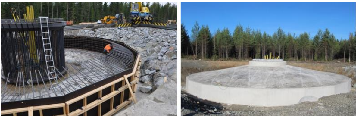
Kuva 4.14 Tuulivoimalan perustusten rakentamista (FCG Finnish Consulting Group Oy).
