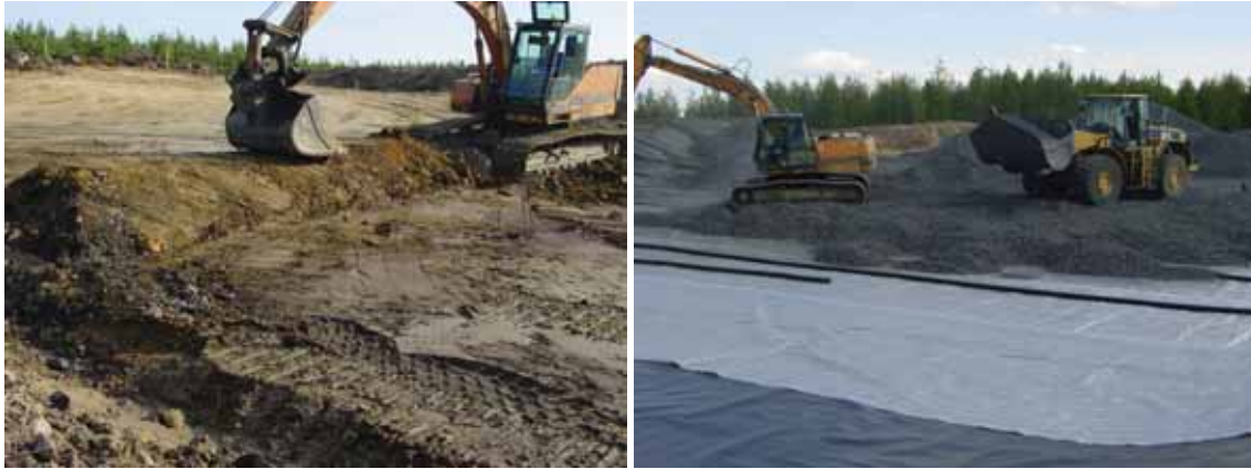
Kuva 4.17. Liutuskasa-alueen maarakentamista ja pohjantiivistystä, Kuusilampi kesäkuu 2005.
