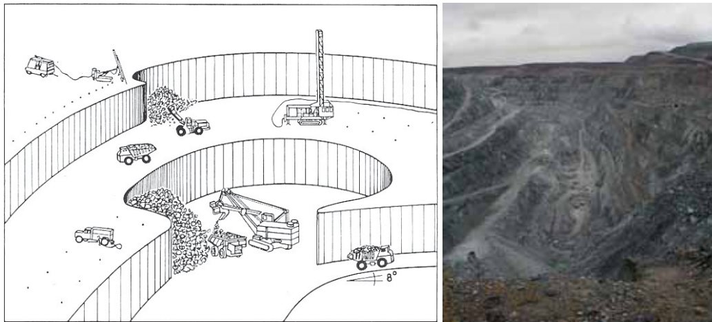
Kuva 4.7. Avolouhinnan periaate ja valokuva Kemin kaivoksen avolouhoksesta.
