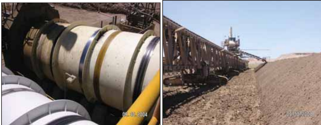
Kuva 7.6. Murskatun malmin agglomerointirumpu ja kasauslaitteisto.
