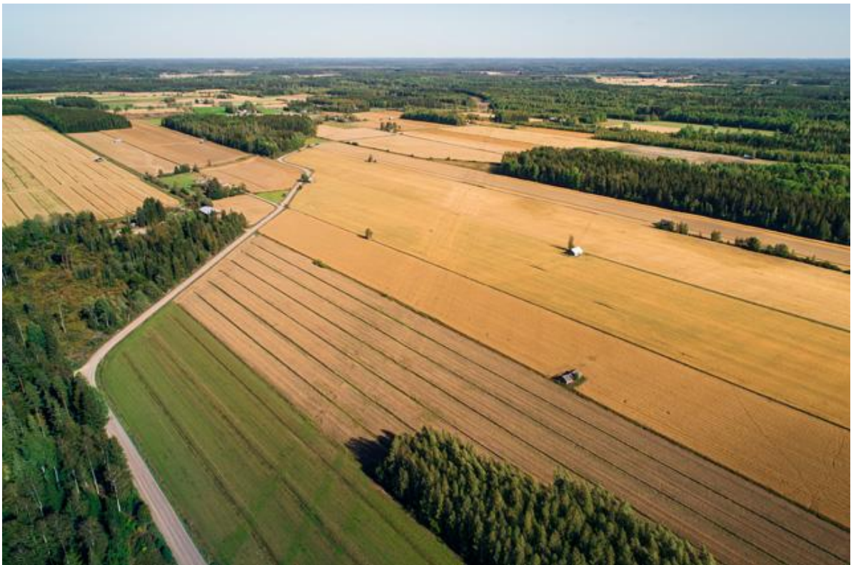
Kuva 3-7. Esimerkkikuva putkilinjan rakentamisen ja viimeistelyn jälkeisestä maisemasta peltoalueella, kun työmaa-alue on palautettu viljelyskäyttöön. Kuva on otettu noin vuosi rakentamisen jälkeen seuraavalla viljelyskaudella. / Exempel på landskapet i ett åkerområde efter att röret dragits, och markytan och området återställts för odlingsbruk. Bilden är tagen ungefär ett år efter byggandet under efterföljande odlingssäsong.
