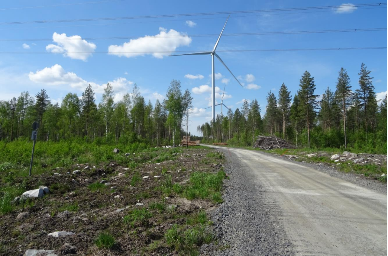
Kuva 13. Esimerkki tuulivoimapuiston rakennus- ja huoltotiestä. Maakaapelin oja on sijoitettu tien vasemmalle puolelle (Kuva: Sweco Finland Oy).
