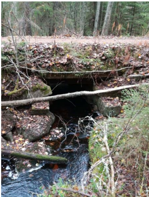
Kuva 24. Sotkanluoma sen ylittävän tien kohdalta kuvattuna. Lähde: Kauhajoen kaupunki 2017, Suolakankaan tuulivoimaosayleiskaavan selostus.
