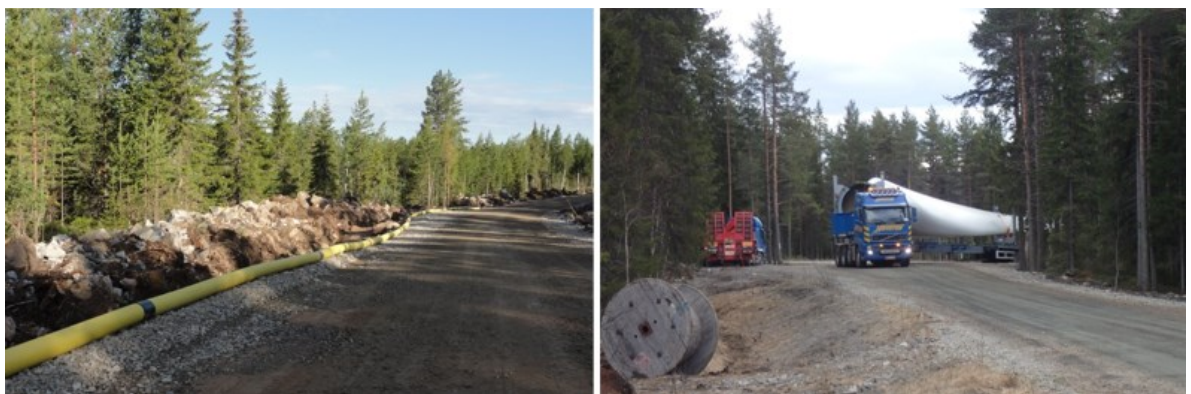
Kuva 5.7 Vasemmalla esimerkki tuulivoimapuiston rakennus- ja huoltotiestä. Oikealla tuulivoimalan osia kuljetetaan erikoiskuljetuksina (FCG Finnish Consulting Group Oy).
