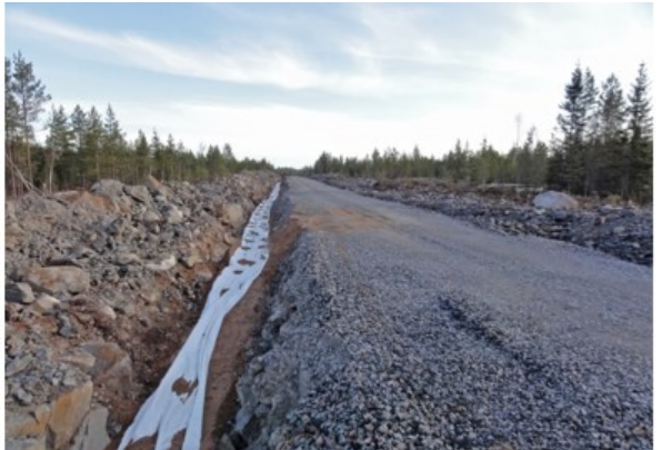
Kuva 5.11 Maakaapelit upotetaan huoltoteiden yhteyteen (FCG Finnish Consulting Group Oy).
