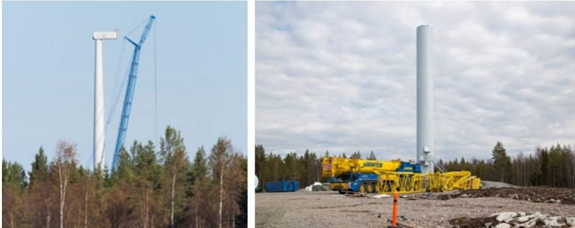
Kuva 5.13 Tuulivoimalan kokoamista (FCG Finnish Consulting Group Oy).
