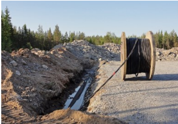
Kuva 5.11 Maakaapelit upotetaan huoltoteiden yhteyteen (FCG Finnish Consulting Group Oy).
