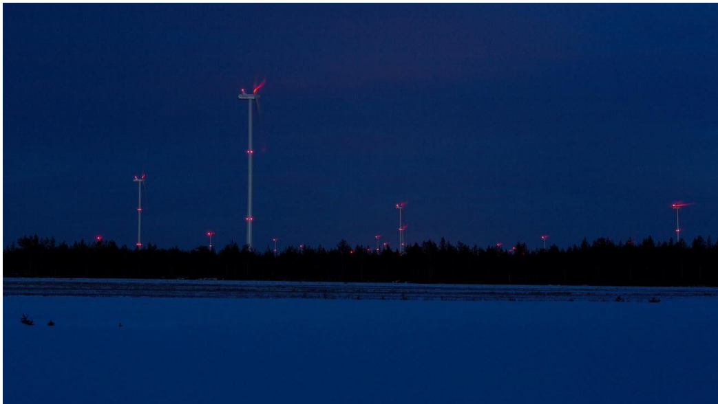
Kuva 5.5 Kiinteät punaiset lentoestevalot (FCG Finnish Consulting Group Oy).
