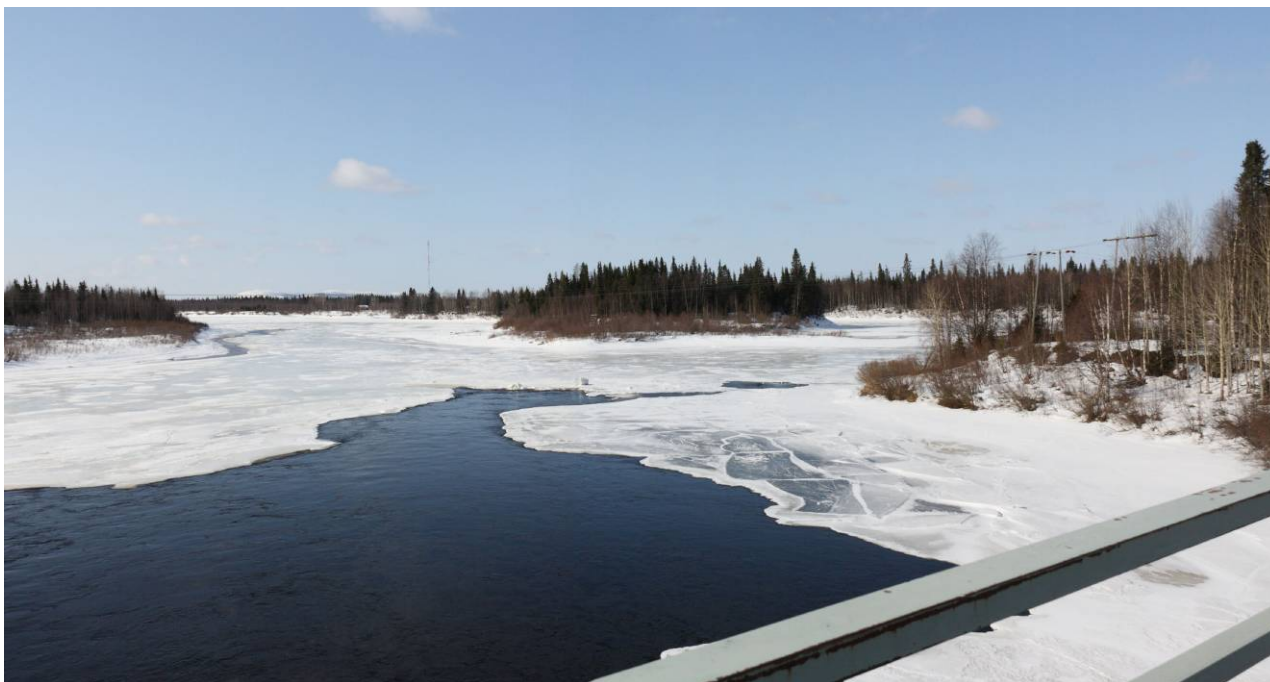
Kuva 7.11 Kitisenjoen ylitys. Kuva maantiesillalta etelään päin katsottuna. (Kuva: Marko Väyrynen)
