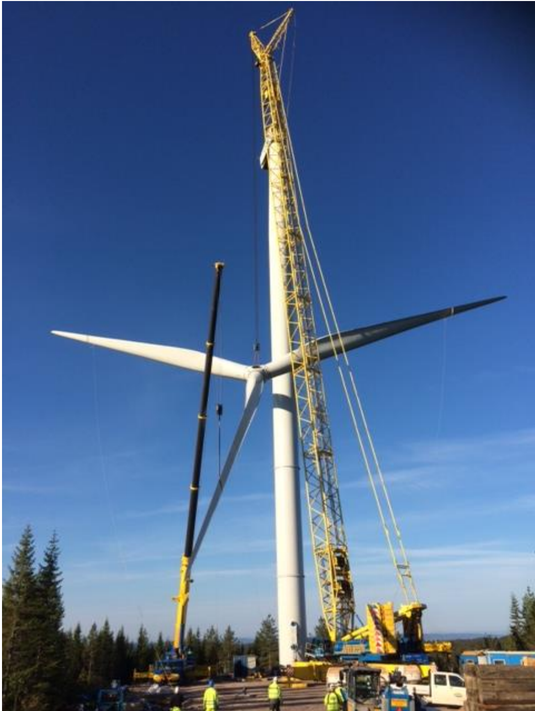
Kuva 13. Roottorin nosto.
