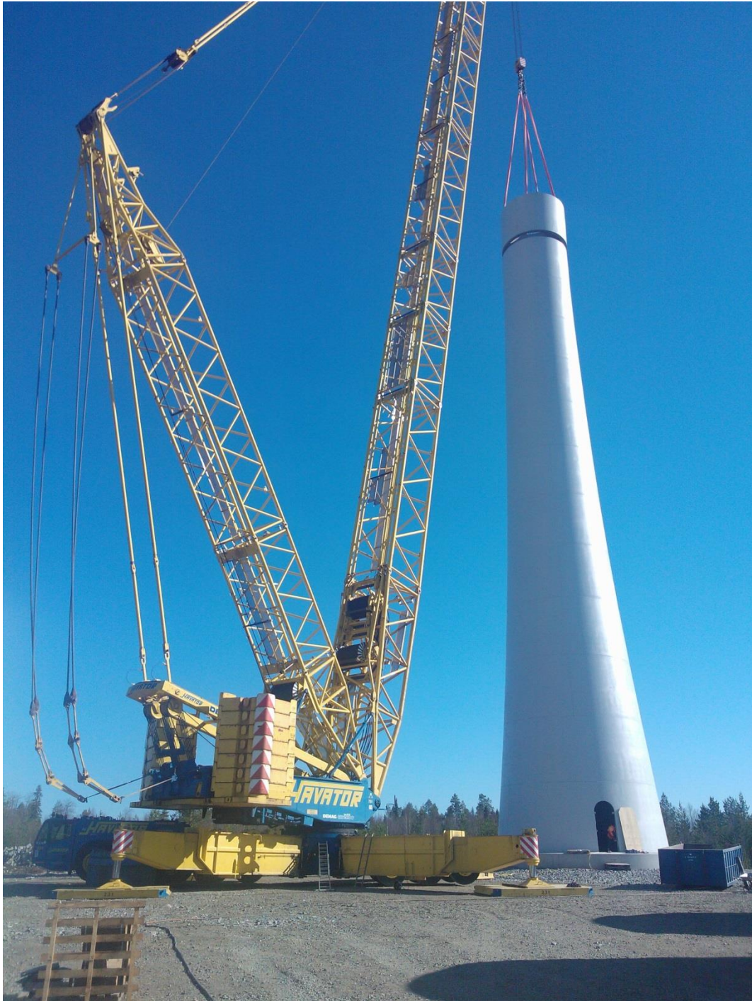
Kuva 10. Tornin alku rakentua.
