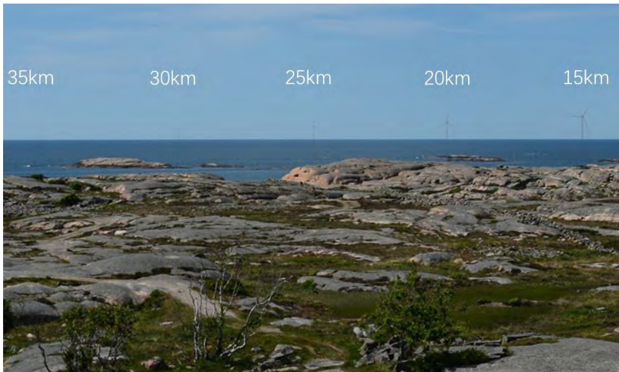
Kuva 40. Herkkyystudkimus siitä, miten tuulivoimalan visuaalinen vaikutus vaihtelee etäisyyden mukaan. Analyysi perustuu 48 mm:n kameraoptiikkaan (vastaa ihmissilmää). Tarkkailija seisoo 25 m merenpinnan yläpuolella, ja tuulivoimalat, joiden kokonaiskorkeus on 370 m, on sijoitettu 15 km:n ja 35 km:n väliselle etäisyydelle 5 km:n välein. Jotta kuva vastaisi paikan päällä koettua mittakaavaa, sitä olisi tarkasteltava etäisyydeltä, joka vastaa neljä kertaa kuvan korkeutta.
