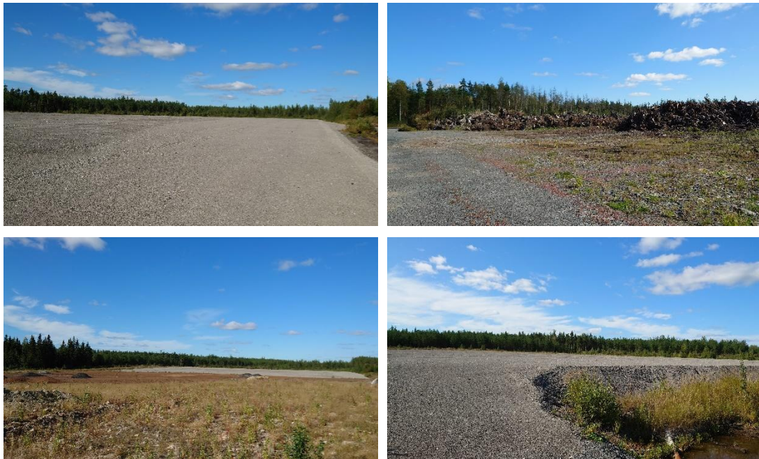
Kuva 4. Näkymiä Pirttikorven kenttärakenteille.
