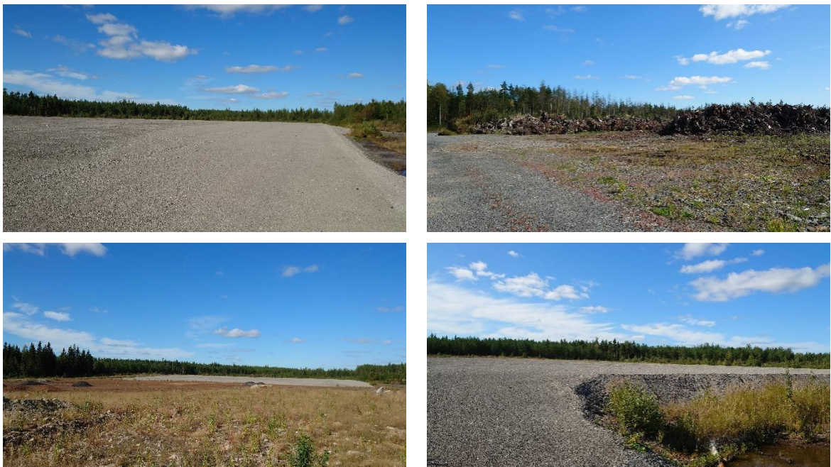
Kuva 3-4. Näkymiä Pirttikorven kenttärakenteille.
