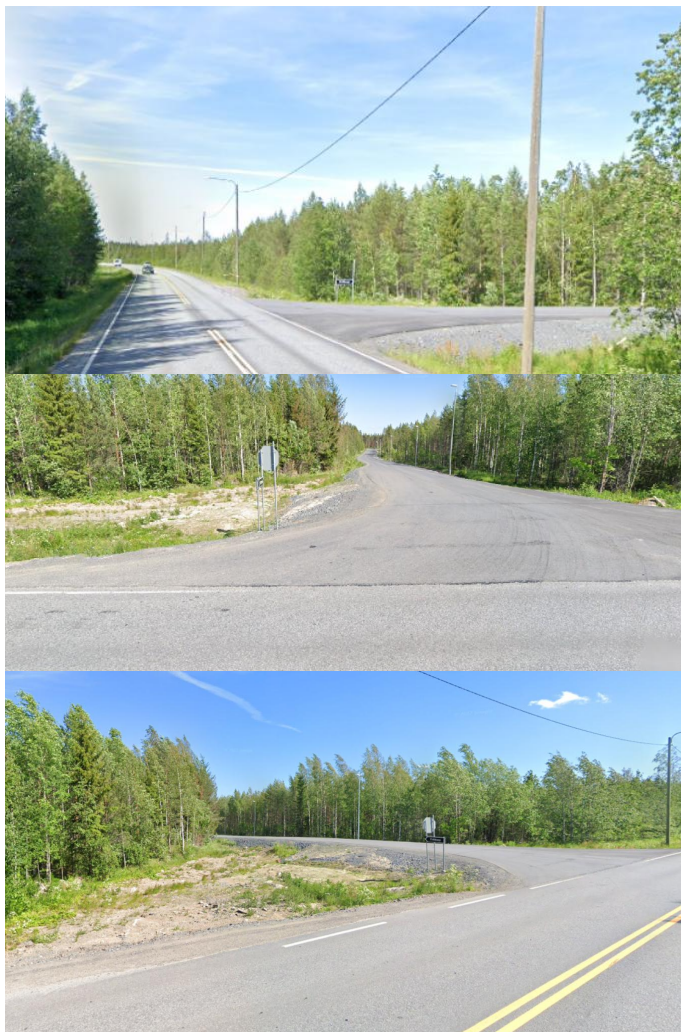
Kuva 15-2. Kuvia liittymästä Seututien 694 liittymästä Teerimäentielle. Ylimmäisessä kuvassa näkymä liittymästä seututietä 694 pohjoiseen, keskellä näkymä Teerimäentielle ja alla näkymä liittymästä kaakkoon.
