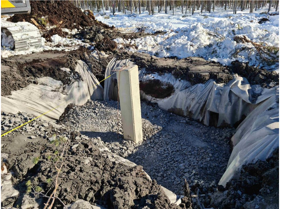
Kuva 3-4. Pylvään perustuselementin asentaminen. Bild 3-4. Installering av stolpfundament.
