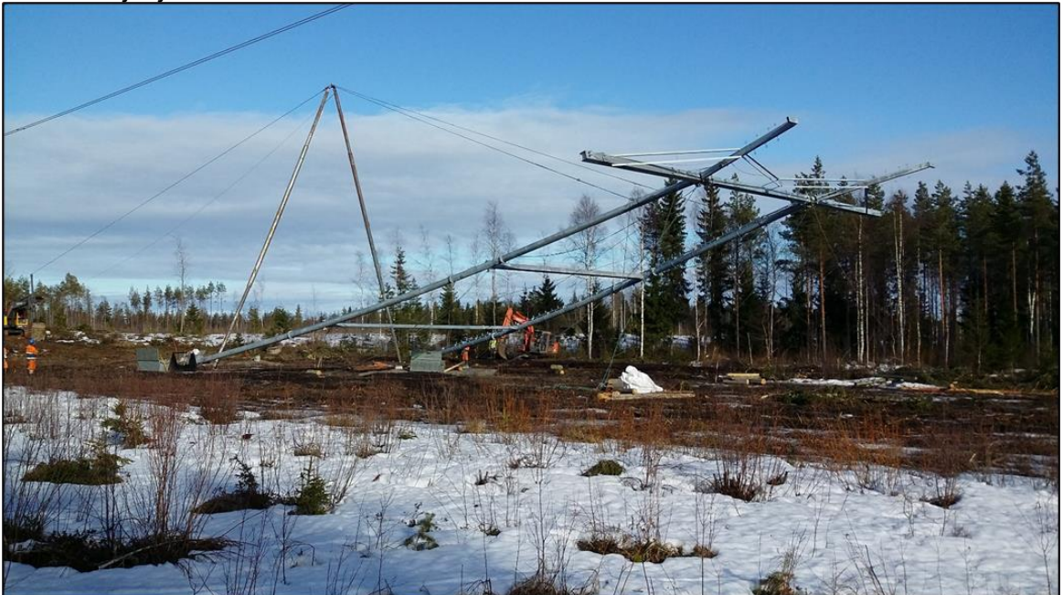
Kuva 3-7. Voimajohtopylvään pystytys.
