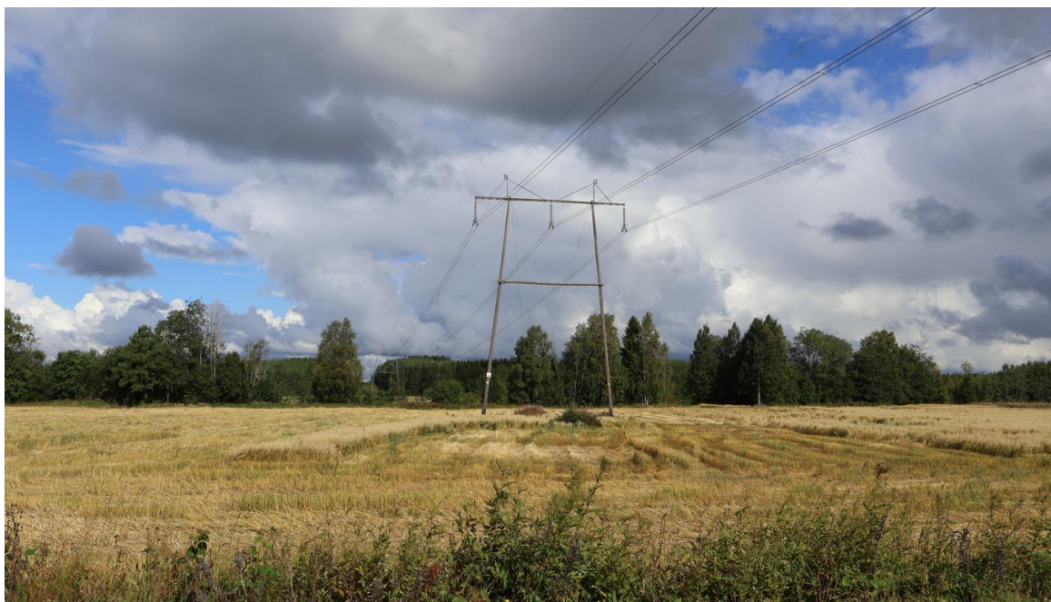
Kuva 6-22. Nykyisen voimajohdon Ähtävänjoen ylityskohta joen eteläpuolelta kuvattuna. Jokirantaa peittää kapea rantapuusto. Suunniteltu voimajohto tulee sijoittumaan samaan maastokäytävään nykyisen voimajohdon paikalle. Bild 6-22. Kraftledningsövergången av Esse å, fotograferad från södra sidan av ån. Stranden täcks av smal strandskog.
