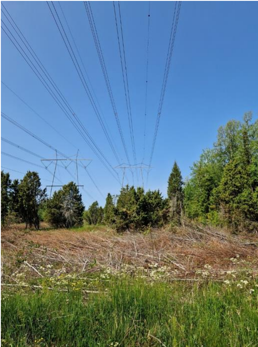
Kuva 3-8. Esimerkki valikoivasta raivauksesta. Bild 3-8. Ett exempel på selektiv röjning.
