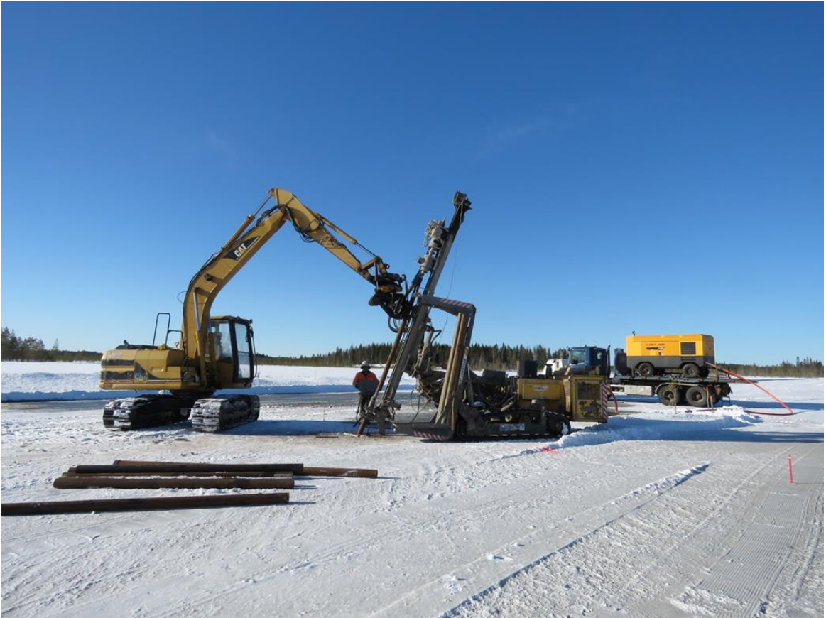
Kuva 3-6. Porapaaluperustuksen tekoa suoalueella, jossa työalue on jäädytetty.
