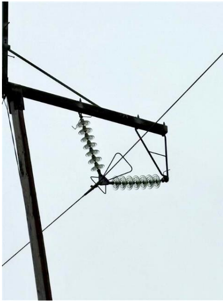
Kuva 6-20. Voimajohtopylvään eristimiä, joissa koronapurkauksia voi esiintyä. Bild 6-20. Isolerade delar av kraftledningsstolpar i vilka det kan förekomma koronurladdningar.
