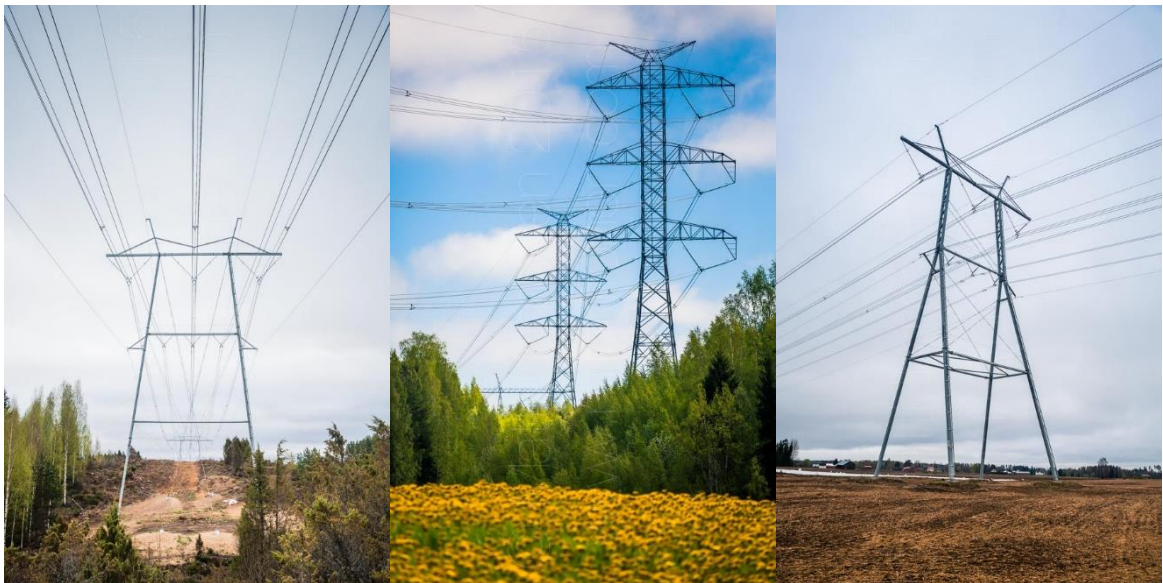
Kuva 4-11. Esimerkkikuvat eri pylvästyypeistä. Vasemmalla haruksin tuettu 400 + 110 kilovoltin portaalipylväs, keskellä vapaasti seisova kahden 400 kilovoltin voimajohtopylväs ja oikealla vapaasti seisova harukseton peltopylväs.
