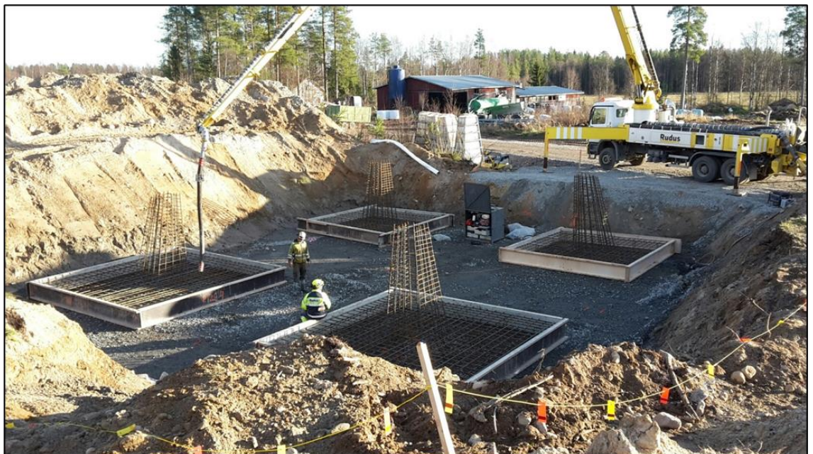
Kuva 3-5. Vapaasti seisovan pylvään perustuksen pohjatöitä. Bild 3-5. Grundläggningsarbete för en fristående stolpes fundament.
