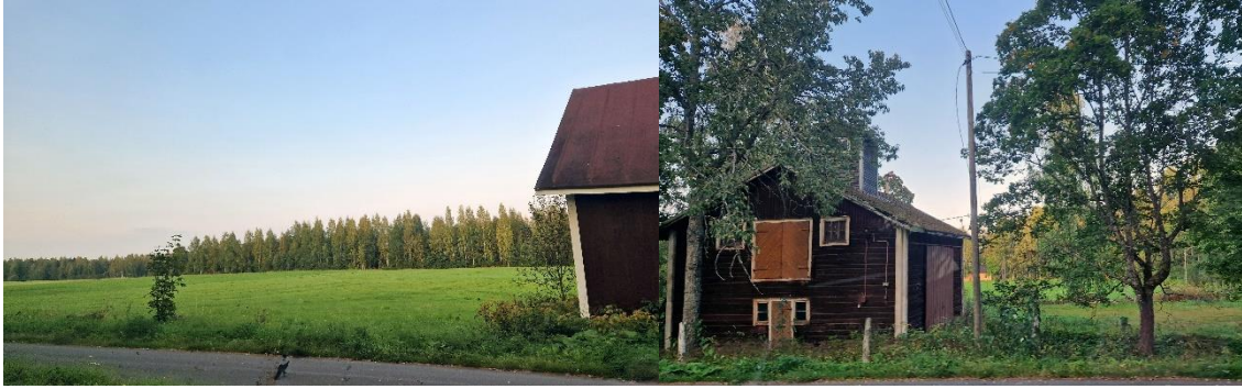
Kuva 13.24 Mäenpään kartanon lukuisat rakennukset ovat ryhmittyneet useiksi pihoiksi harjanteen reunalle, peltojensa keskelle. Pihapiireissä on pienipiirteisyyttä, mutta pääasiassa harjanteella olevien rakennusten sijainti on avoimessa maisematilassa. Valokuvat Pohosjoentieltä koilliseen päin rakennusten, pihan ja viljelyalueen suuntaan.
