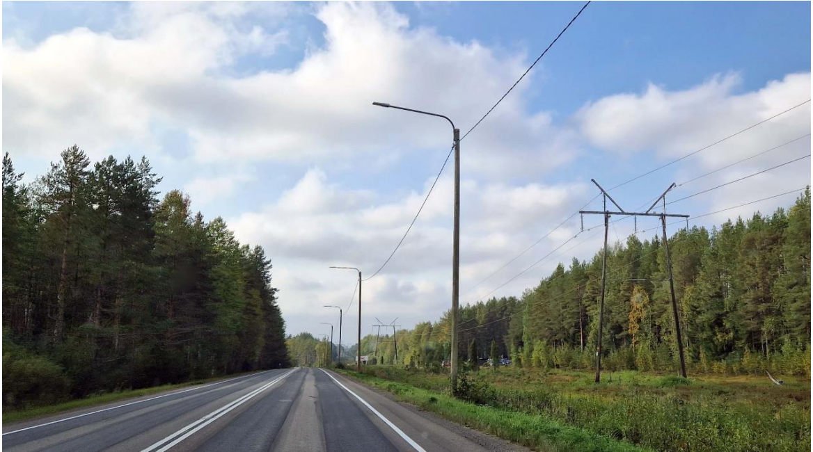
Kuva 13.9 Voimajohtolinjat ovat tavallisimmin maisemassa näkyviä ympäristöhäiriöitä, joilla on verraten lyhytaikaisempi ja lievempi vaikutus maisemarakenteeseen kuin maisemavaurioilla.
