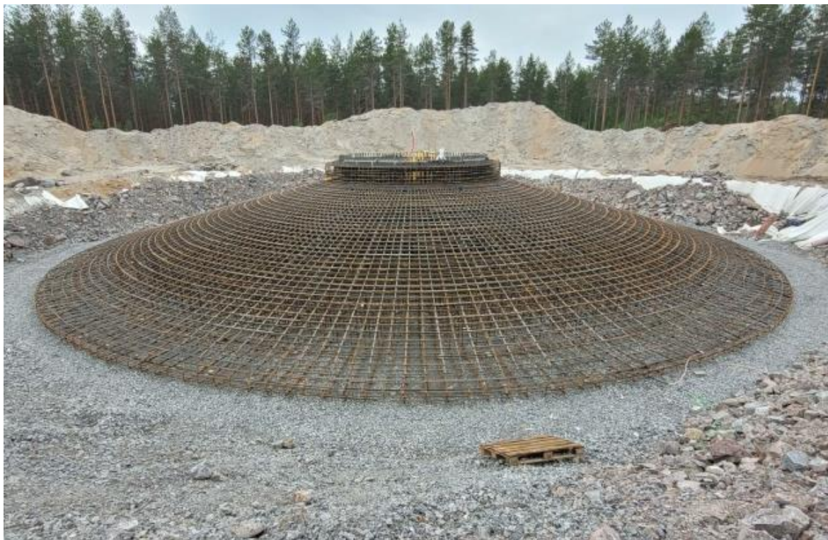
Kuva 4.2 Tuulivoimalan perustukseen käytetään paljon betonia ja terästä. Etualan kuljetuslava antaa osviittaa mittakaavasta. Lähde: POP-ELY. Kuva: Ramboll Finland Oy.
