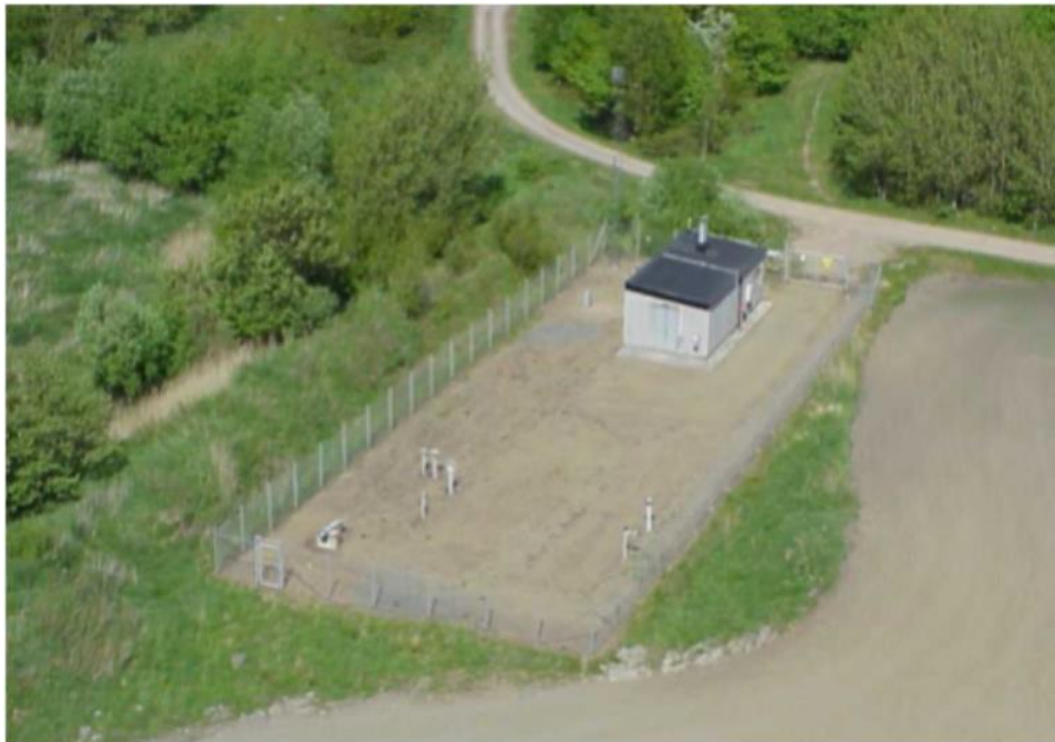
Kuva 7. Esimerkki mittaus- ja säätöasemasta. Kuvassa on nykyinen maakaasujärjestelmä. Lopullisessa vaiheessa saattaa esiintyä muutoksia.
