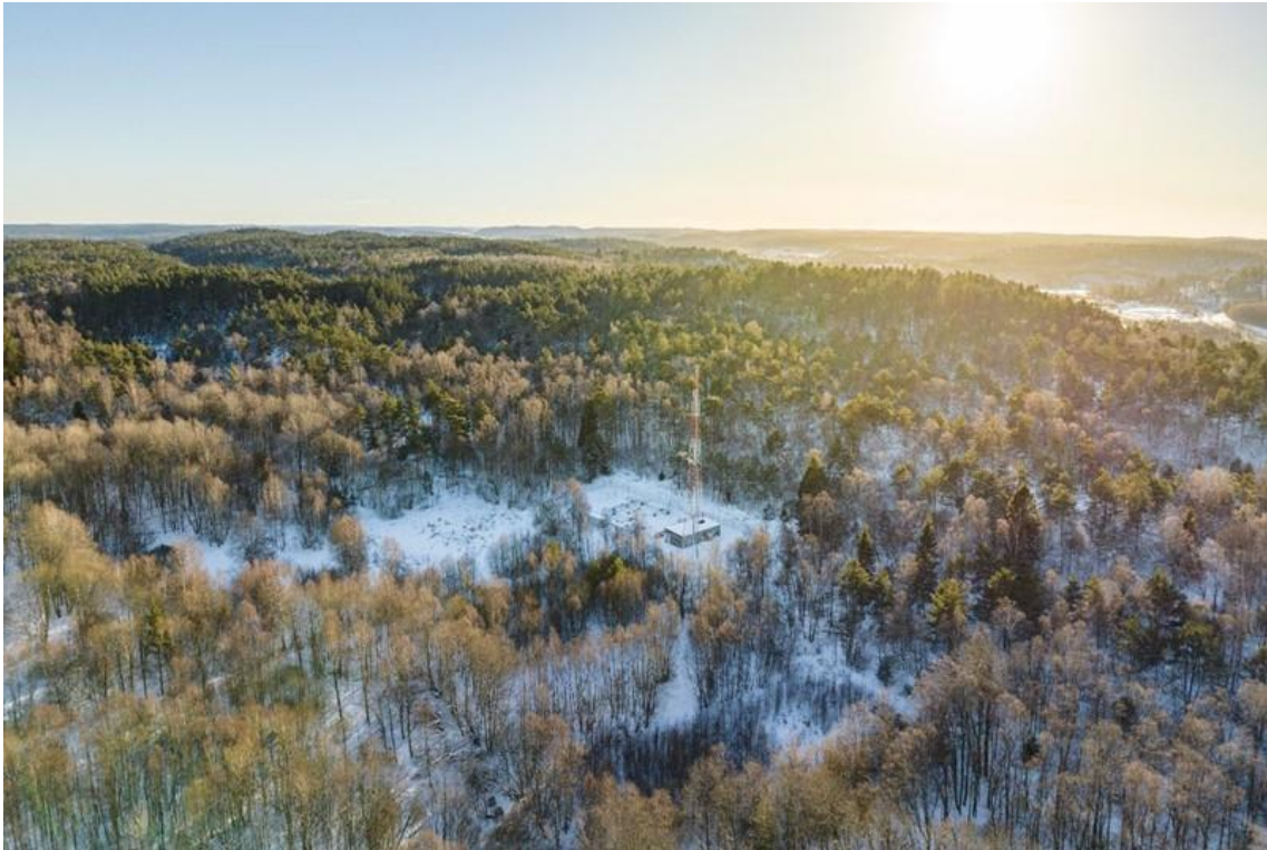
Kuva 11. Kuva linjaventtiiliasemasta sekä johtoaukeasta. Kuvassa on nykyinen maakaasujärjestelmä. Lopullisessa vaiheessa saattaa esiintyä muutoksia.
